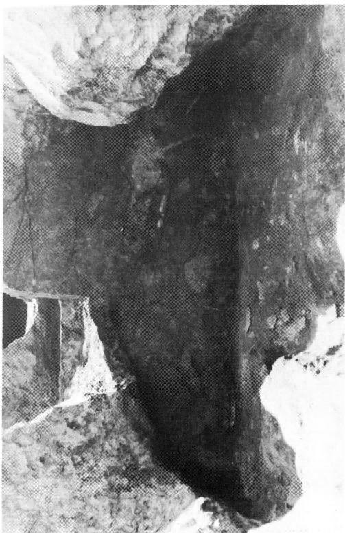
焼成部天井残存部
