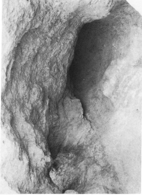
SX1 トンネル部
