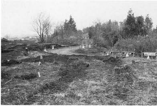
安全設備付設状況
