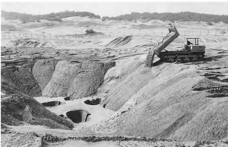
埋め戻し作業風景
