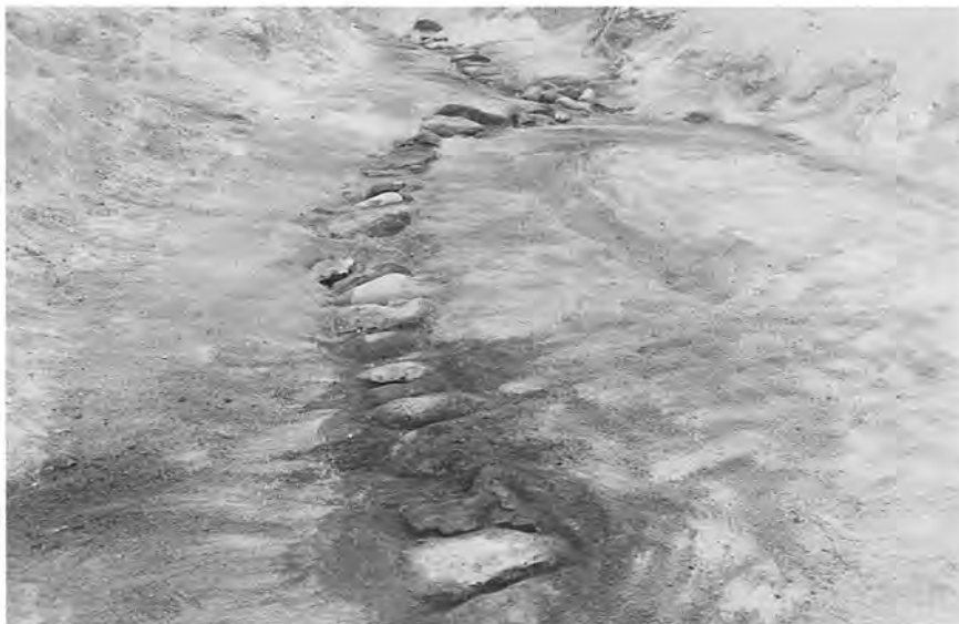
第15号土樋確認状況
