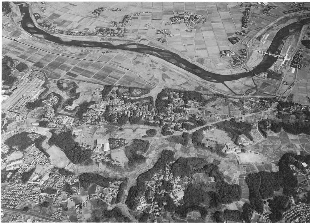
甚五郎崎・下高井向原Ⅰ・下高井向原Ⅱ遺跡遠景
