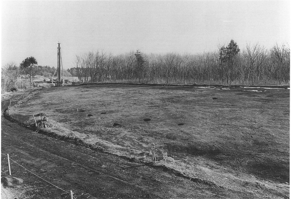
調査終了状況
