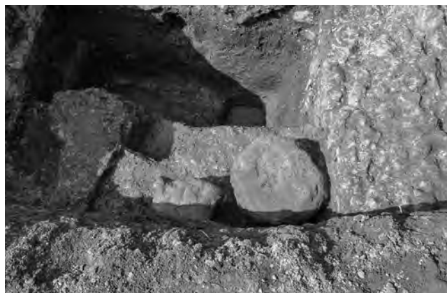
2. I区第2面 礎石建物1 礎石1・4(南から)
