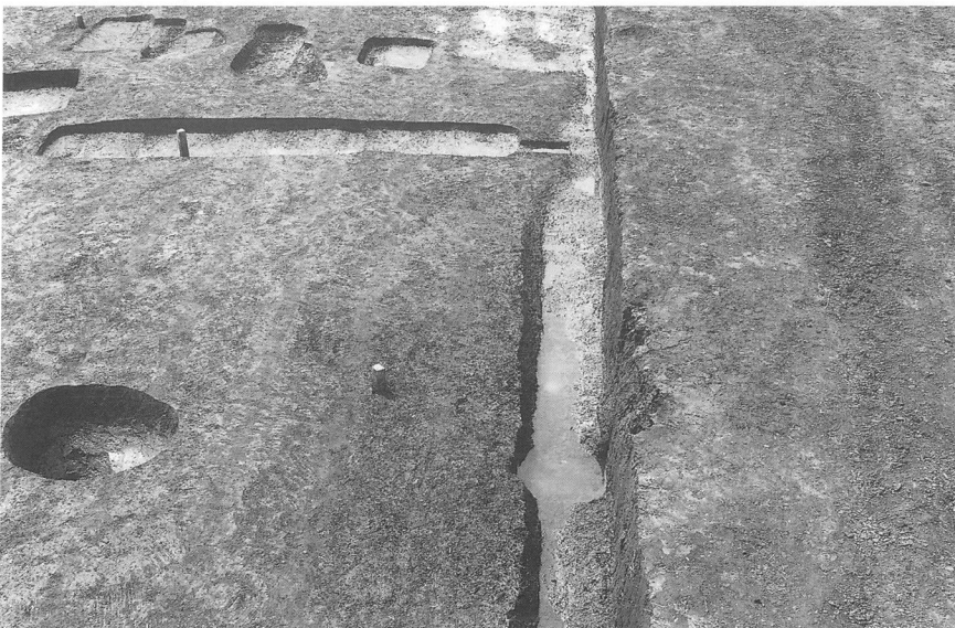
第3号溝完掘状況
