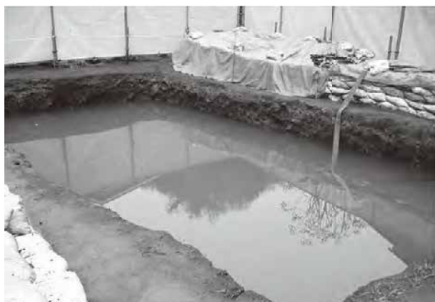
1. I区冠水状況（南東から）
