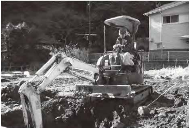
2. I区表土掘削（南東から）
