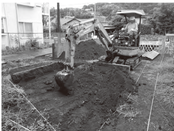
2. I区 表土掘削状況 (北から)
