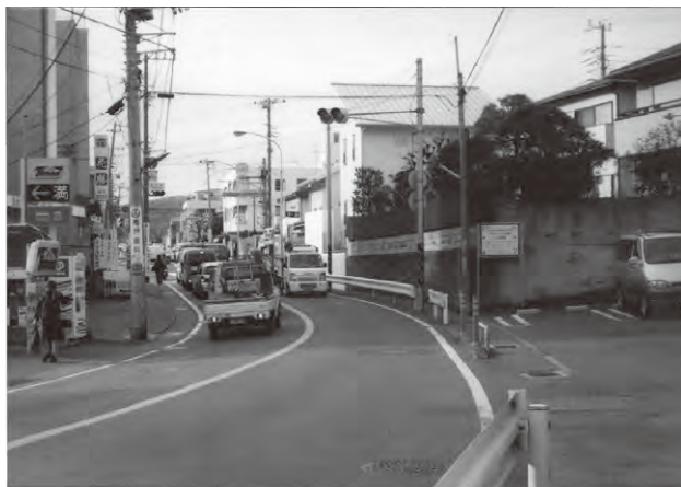
1-2 近景、県道204号線(六浦路)(東から)
