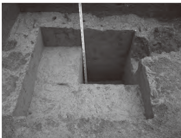
7. II区 ローム層確認坑 (西から)
