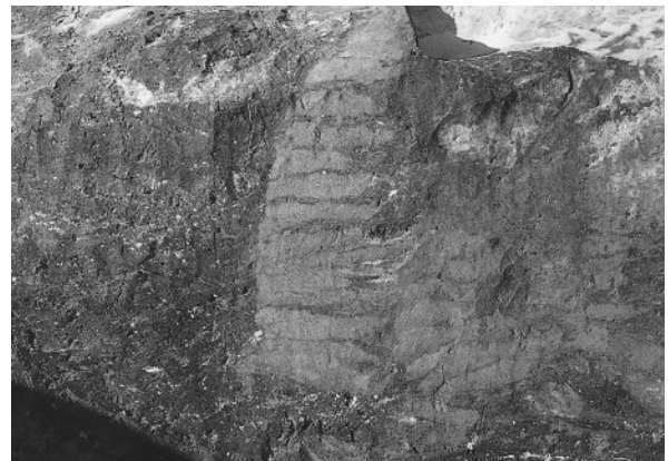
釜屋内版築状況
