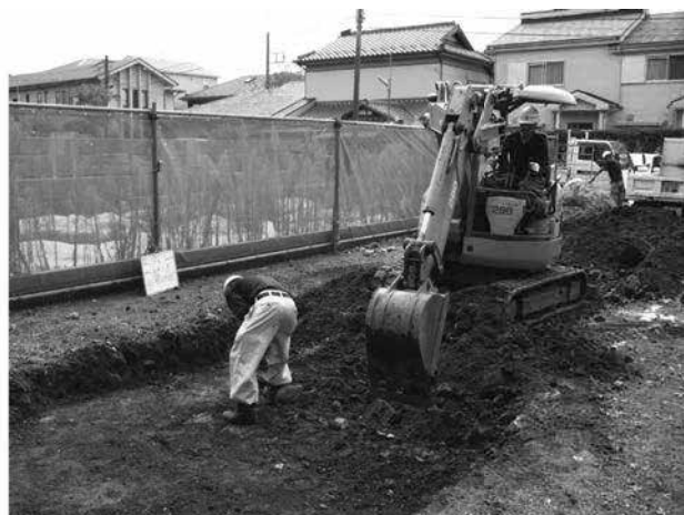
2. I区表土掘削状況 (北西から)
