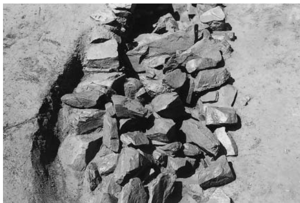
第13号墳 玄門部石材崩落状況
