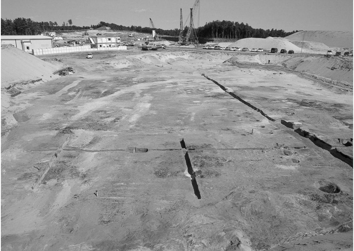
6区完掘全景（南から北へ）
