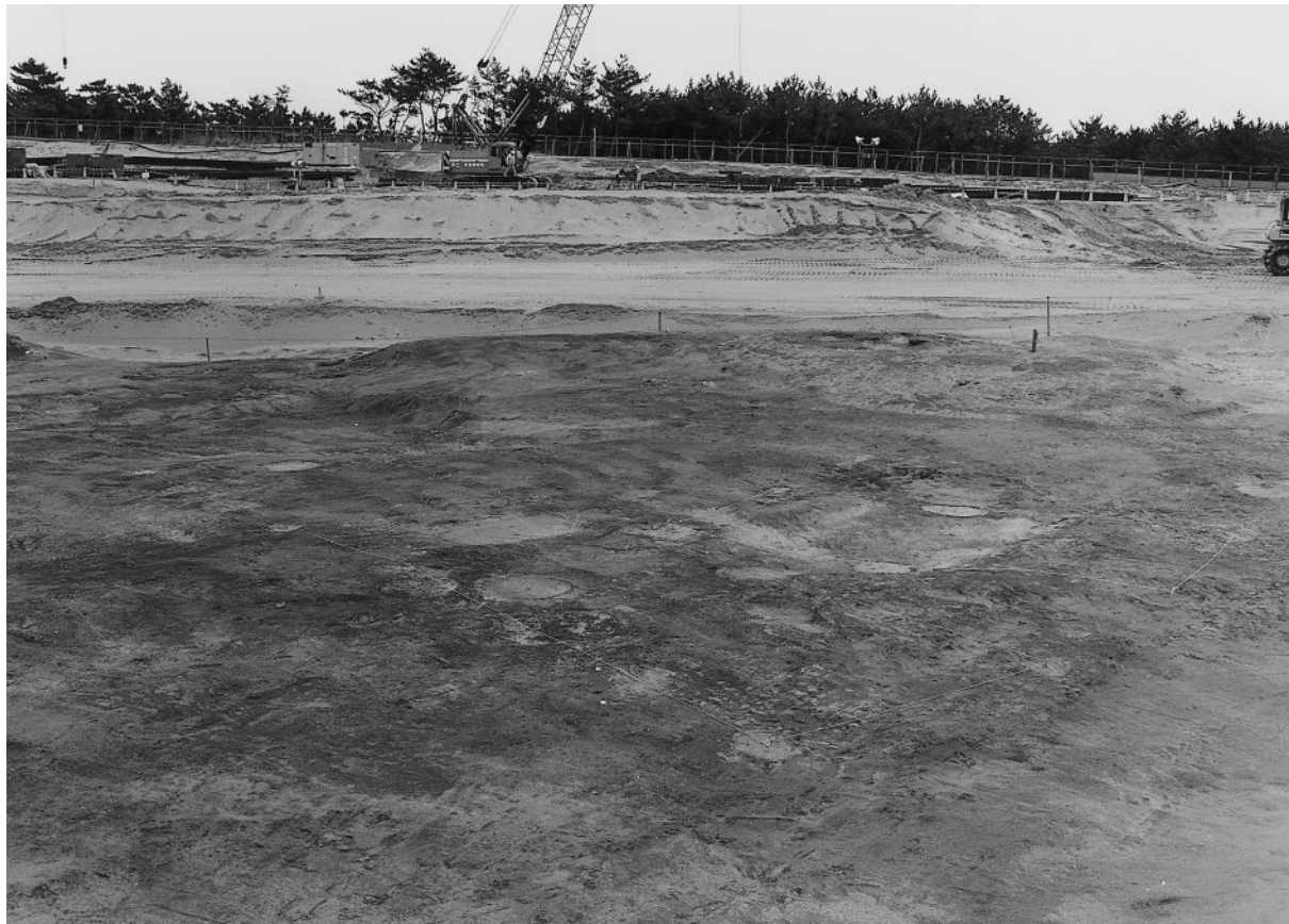
9区遺構確認状況（中央部）
