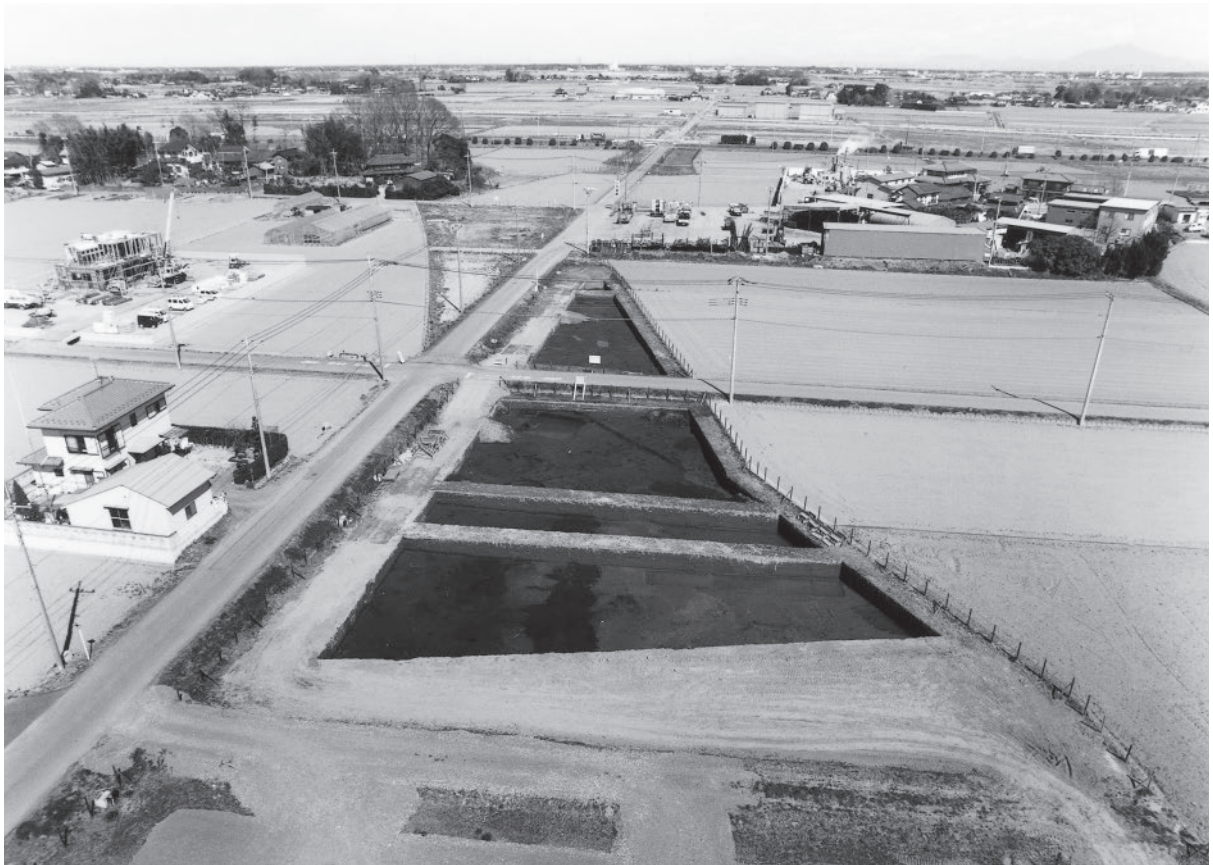
全 景 (南西方向から)
