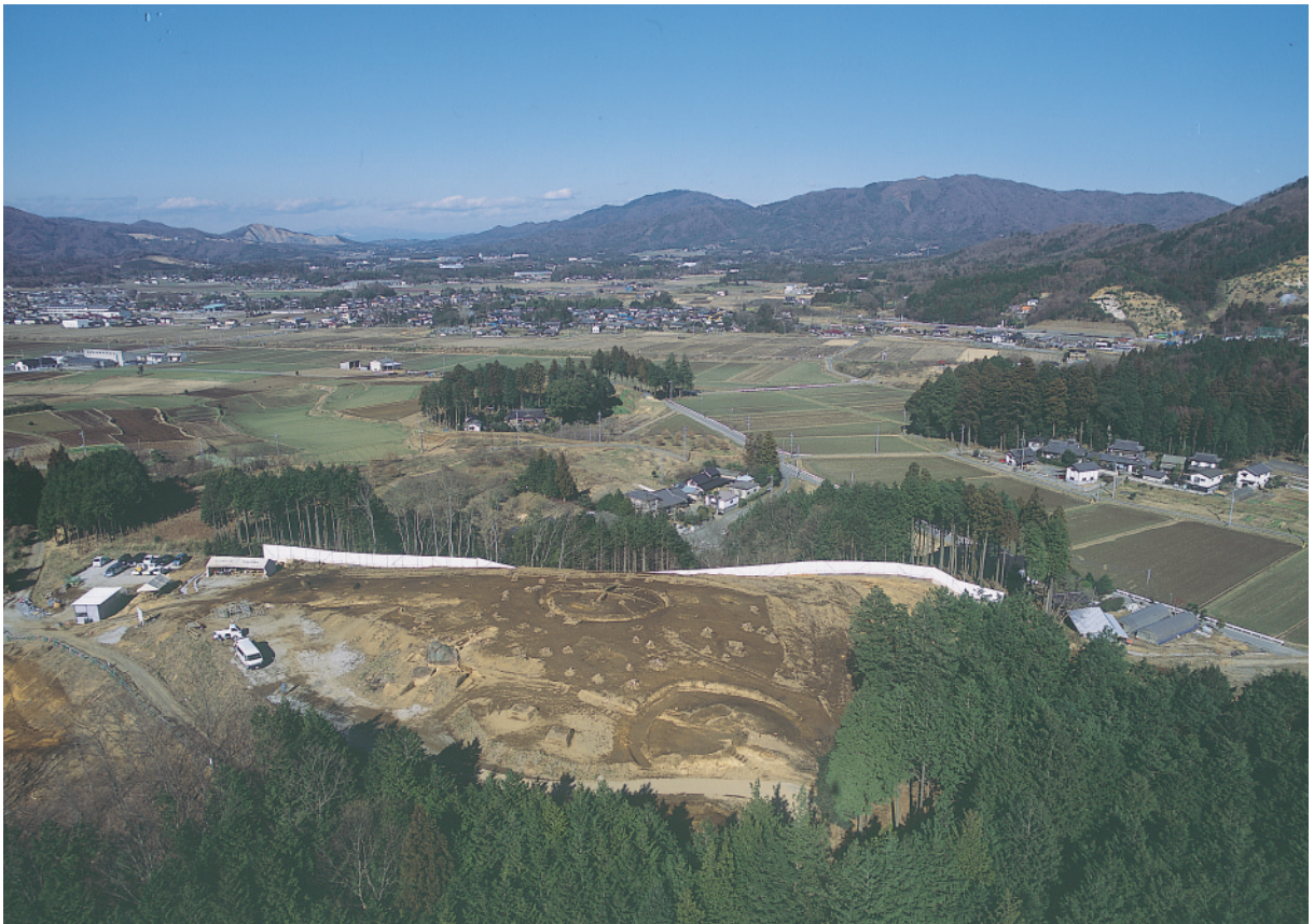
調査区中央部全景（南から）
