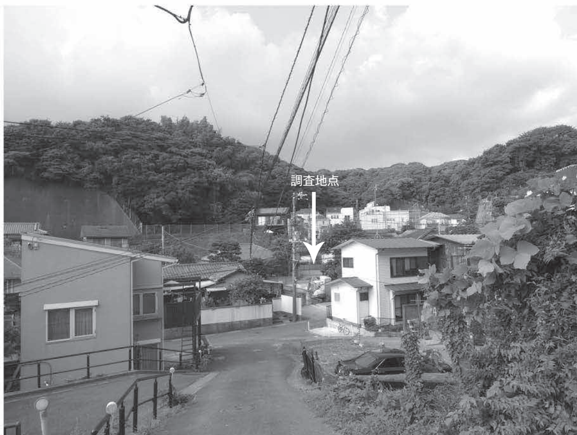
▲1. 調査地点遠景（南西から）
