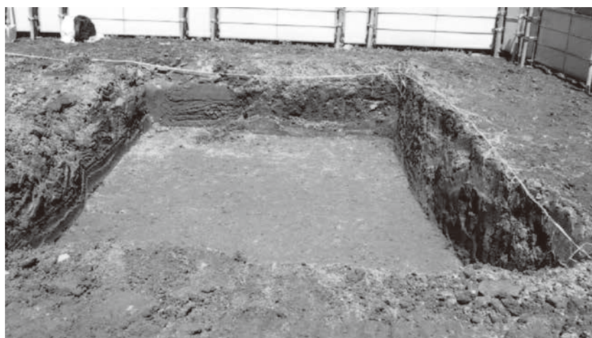
▼ C. 表土掘削後の調査区 (南から)
