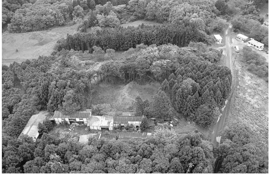
第 5 号 掩 体 壕 全 景
