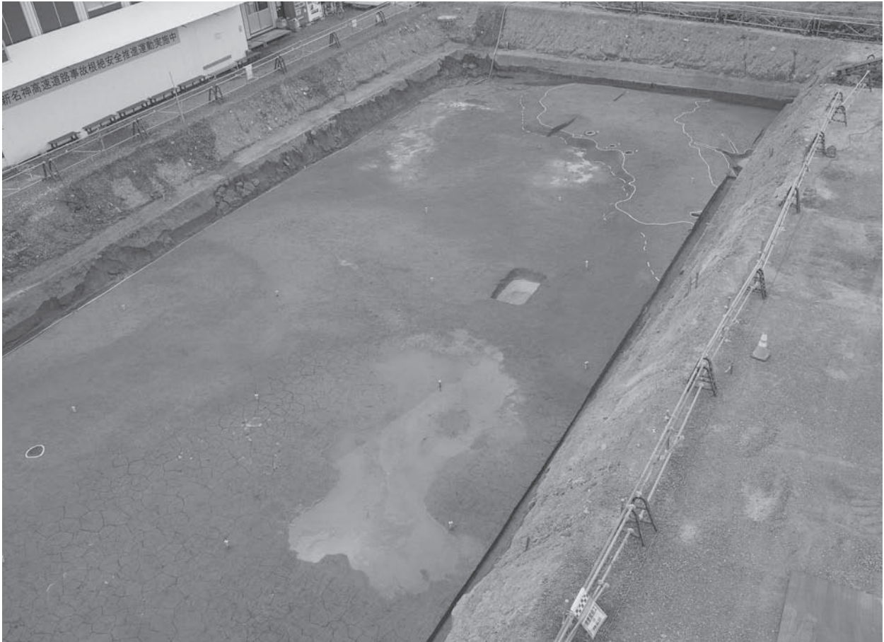
19-1 調査 2トレンチ 全景 (東から)
