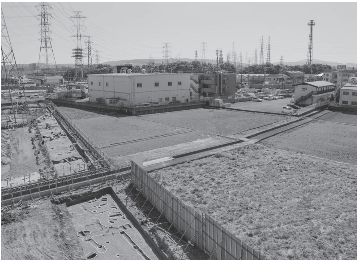
調査地より生駒山地方方向を望む（北西から）
