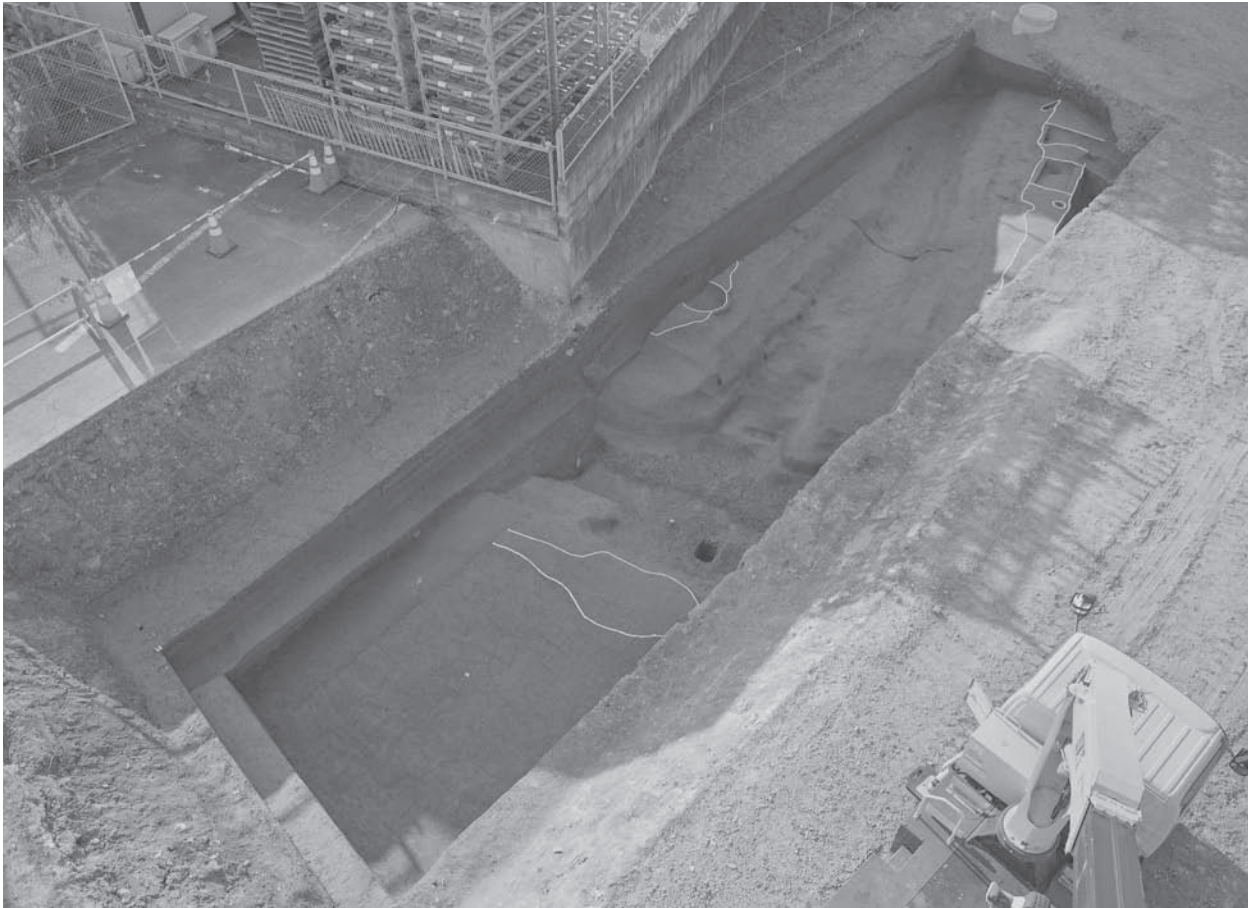
20-1調査 5トレンチ 全景(東から)
