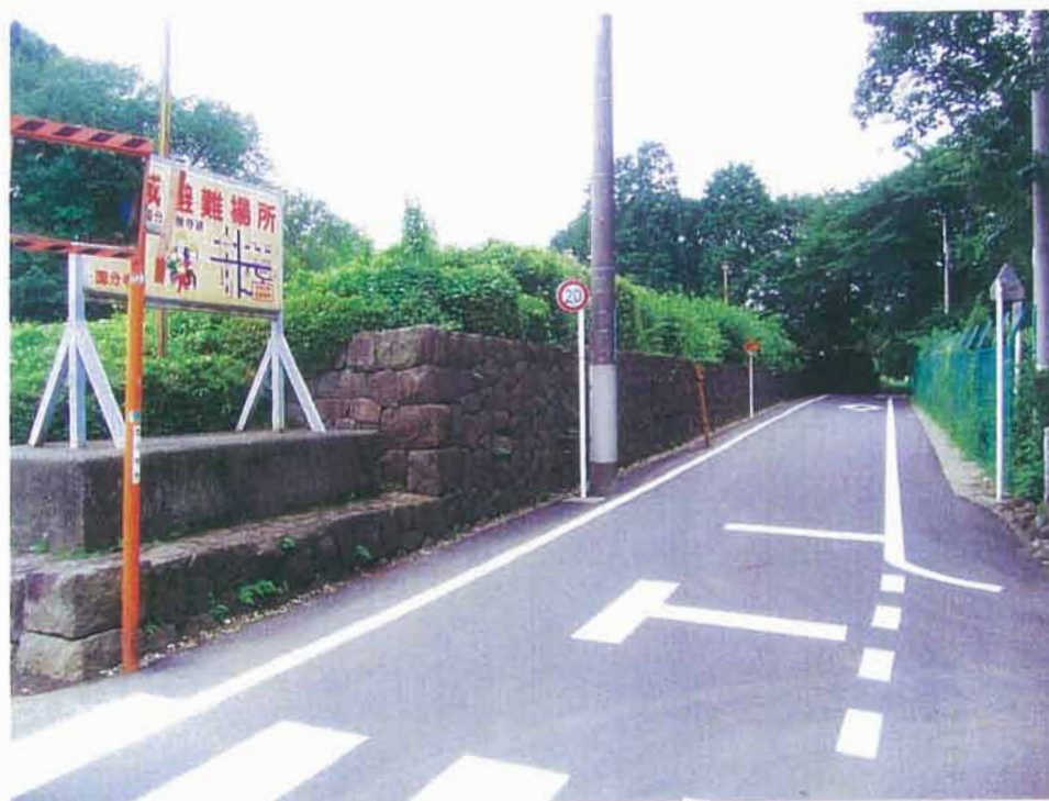
D 同じく入口付近。元町通り沿いに高く積まれた石垣が史跡の連続性を阻害している印象を受ける。
