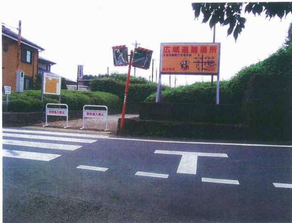
C お鷹の道から中枢地区（講堂・金堂地区）への入口の現況。サインもなく入口であることがわかりづらい。前に置かれたミラーと看板が目立つ。
