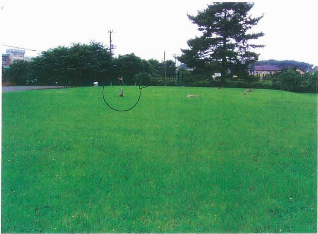
G 金堂基壇の現況。基壇上に礎石が点在する。金堂跡の標柱はほとんど目立たない
