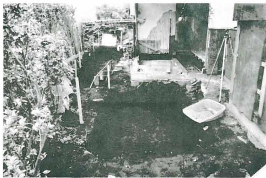
2. B地区全景 西から
