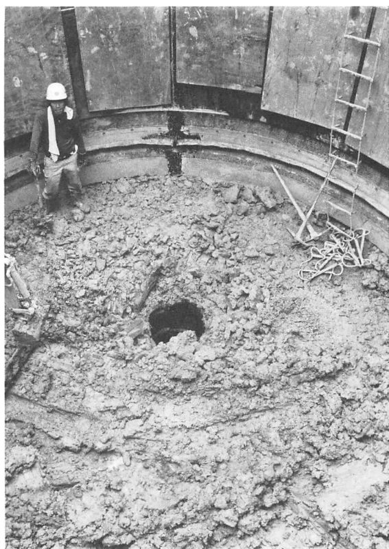
1 井戸検出状況(北東から)
