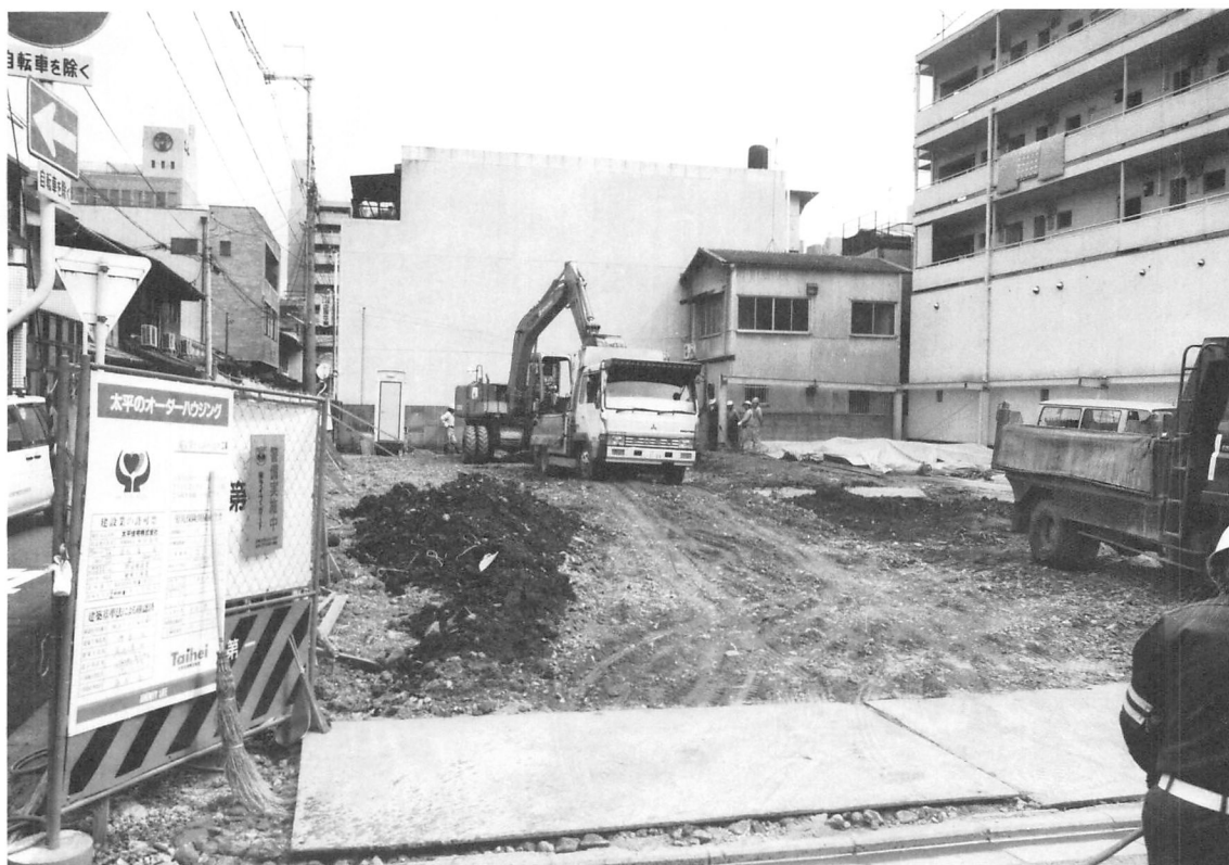
1 調査区全景 (南から)
