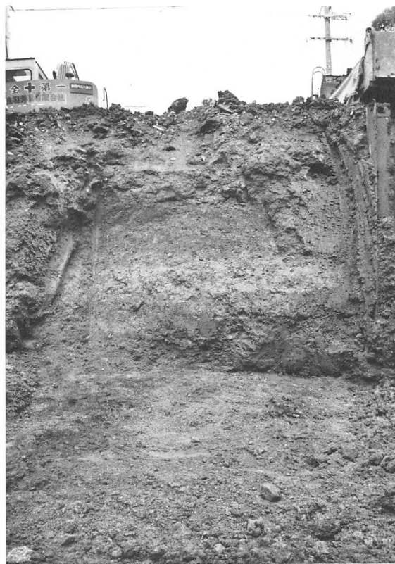
2 No. 3 地点断面 (東から)
