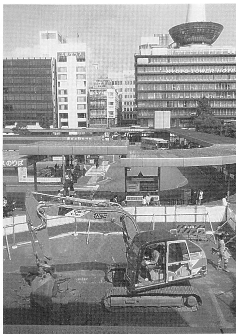
写真12 5トレンチ掘削中(南から)
