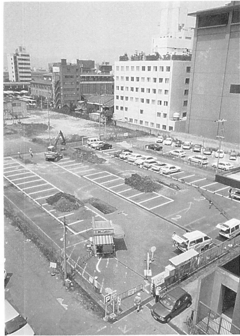
写真10 調査地遠景(南東から)
