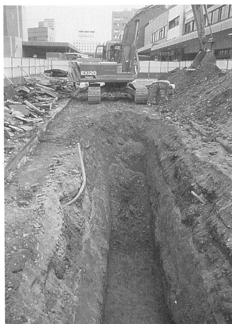
写真11 1トレンチ全景(西から)
