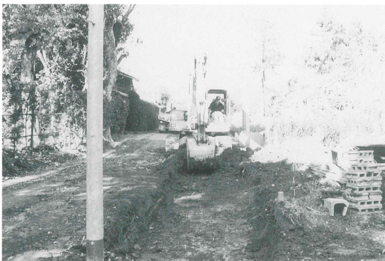
重機掘削風景（第3調査区）
