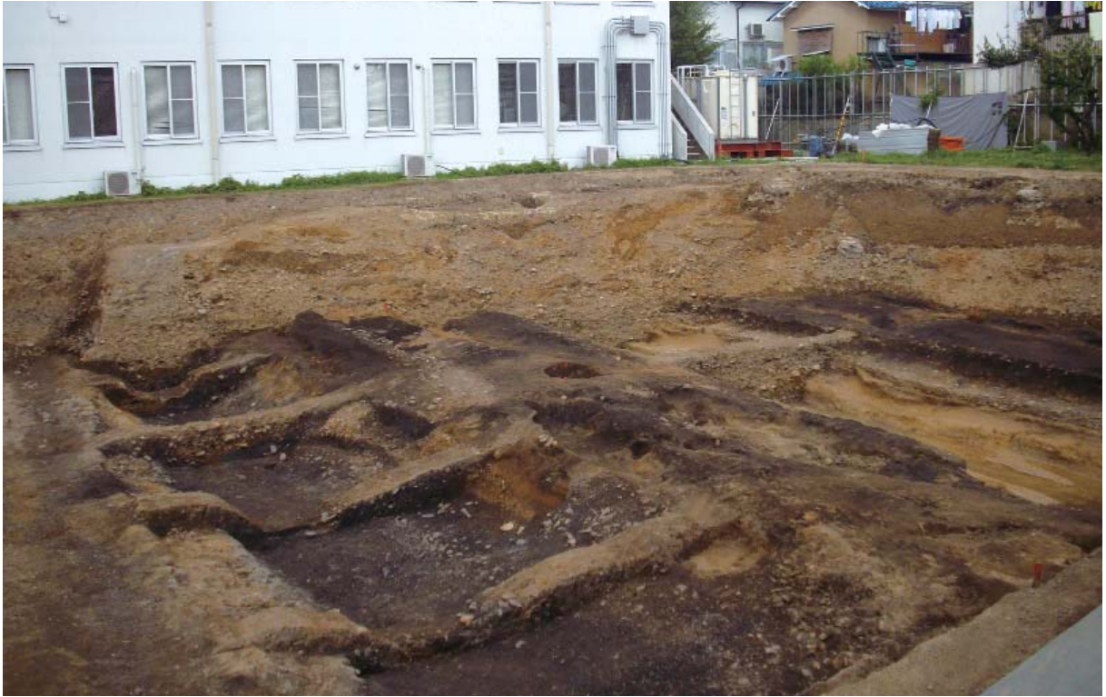
写真手前が西堀川小路西側溝、右手が西堀川、奥の断面の礫層が洪水堆積。(南西から)
