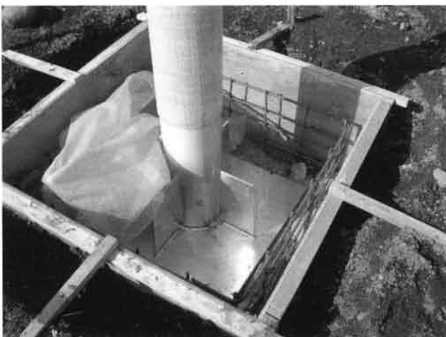
掘立柱据付状況
