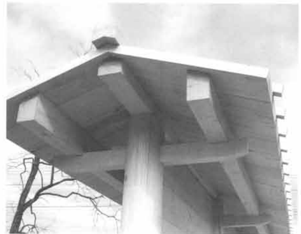
板屋根内部見上げ
