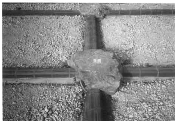
礎石及び壁表示施工状況
