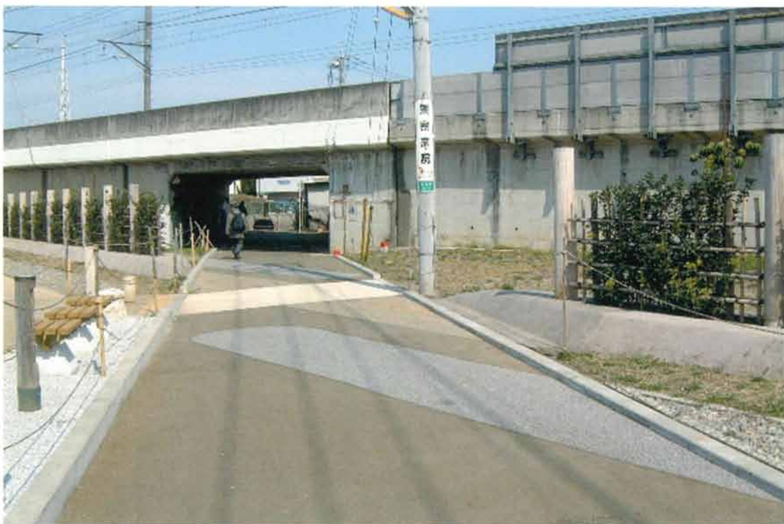
中枢地区東面塀・東門
