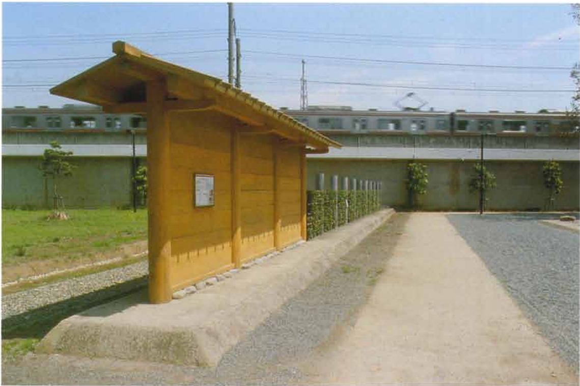
中枢地区北面塀
