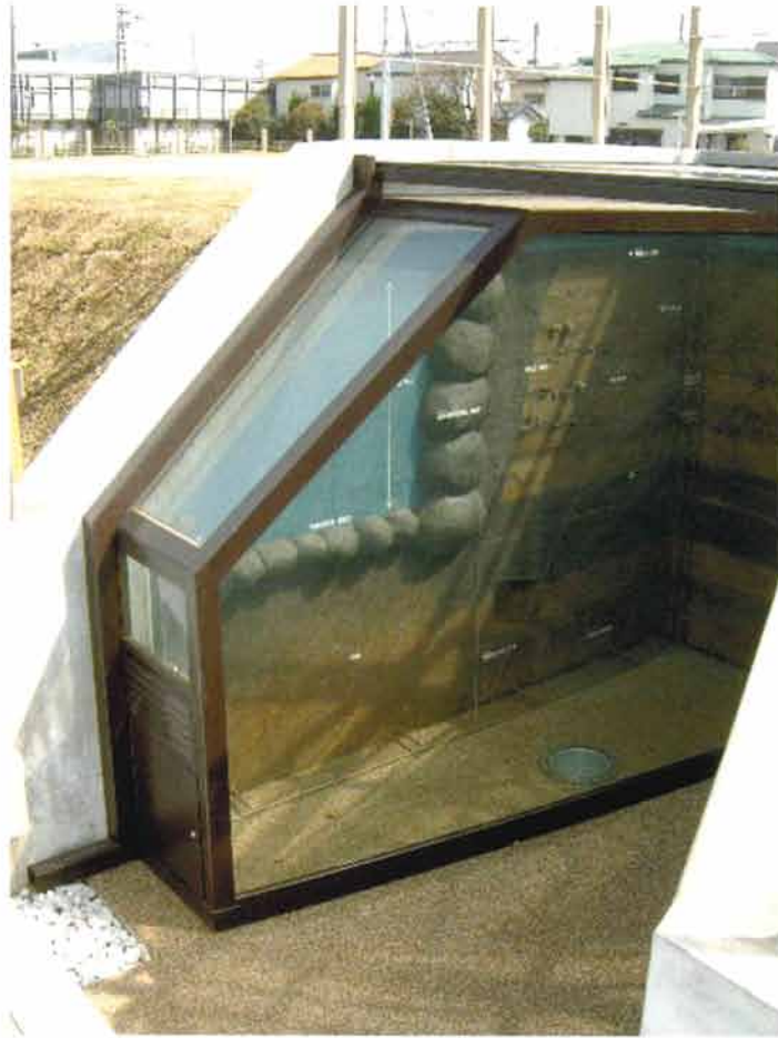
金堂基壇版築観察施設
