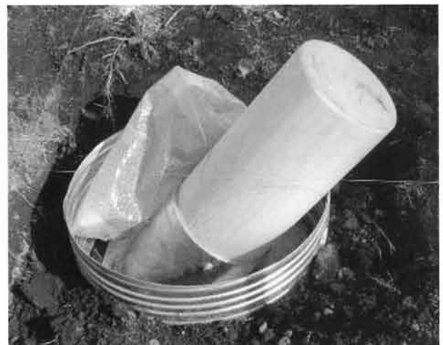
斜め建て支柱据付状況
