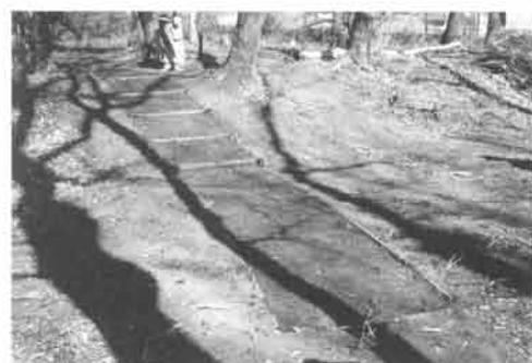
園路および階段設置状況
