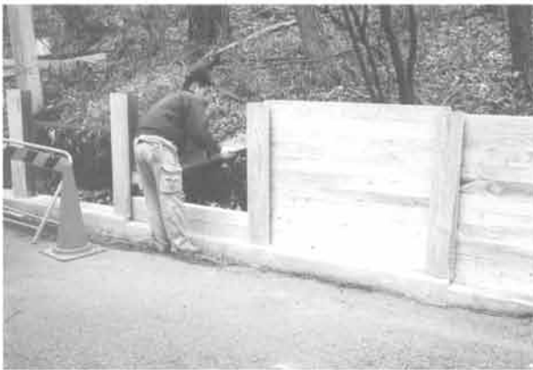
土留壁設置状況
