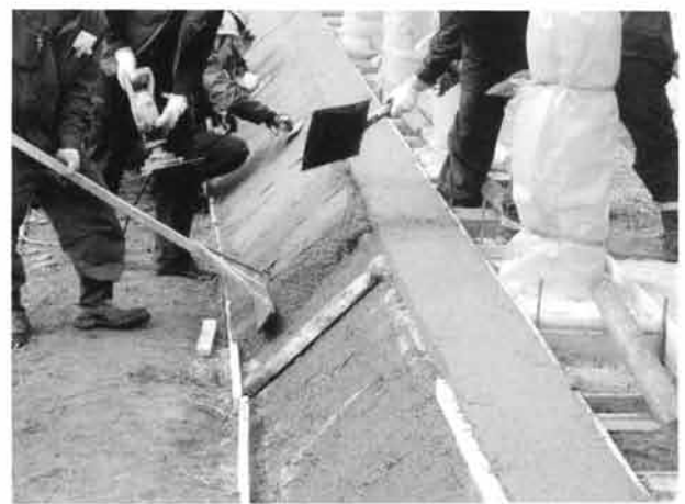
基壇法面施工
