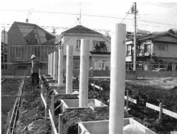
掘立柱立柱状況
