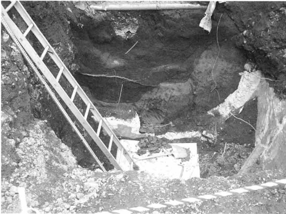
図 3-4 平成 19 年 2 月 20 日 溝遺構下部地山部分における排水管取り付け穴位置確認
