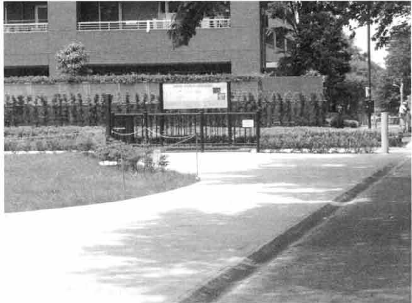
図 5-1 入口広場舗装整備状況
