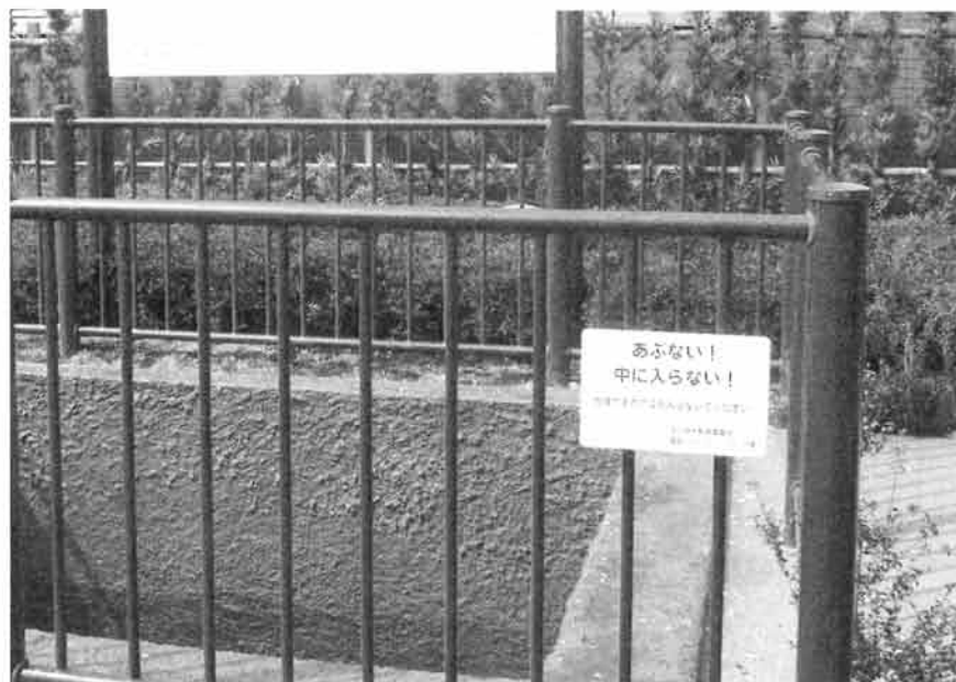
図 5-21 利用注意看板整備状況
