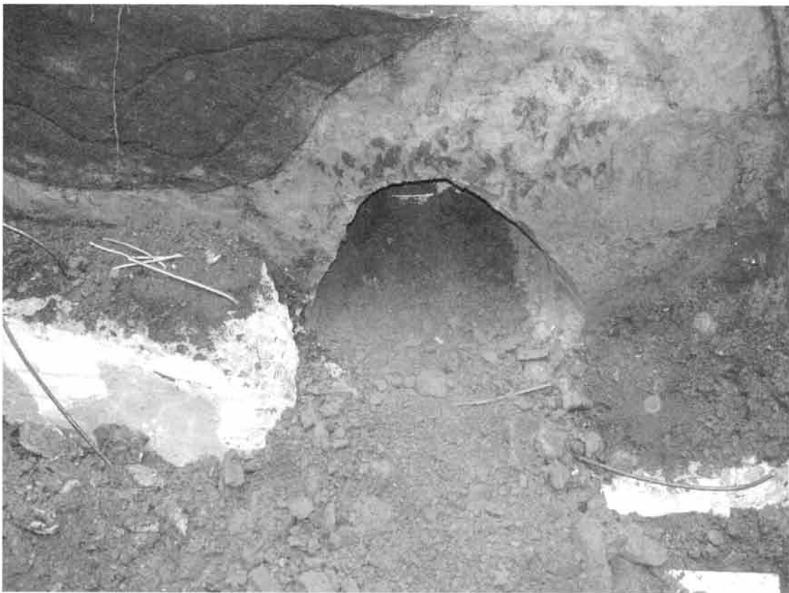
図 3-5 平成 19 年 2 月 20 日 溝遺構下部地山部分における排水管設置穴の掘削状況
