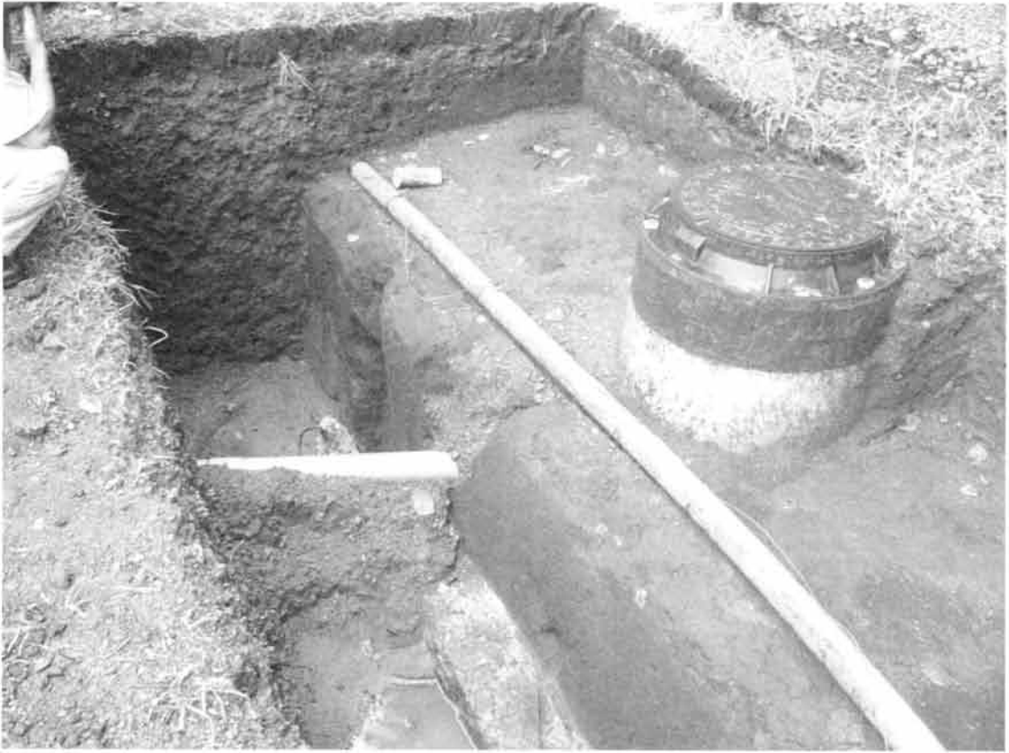
図 3-2 平成 18 年 8 月 8 日 事前遺構確認調査 既設人孔付近 南西より
