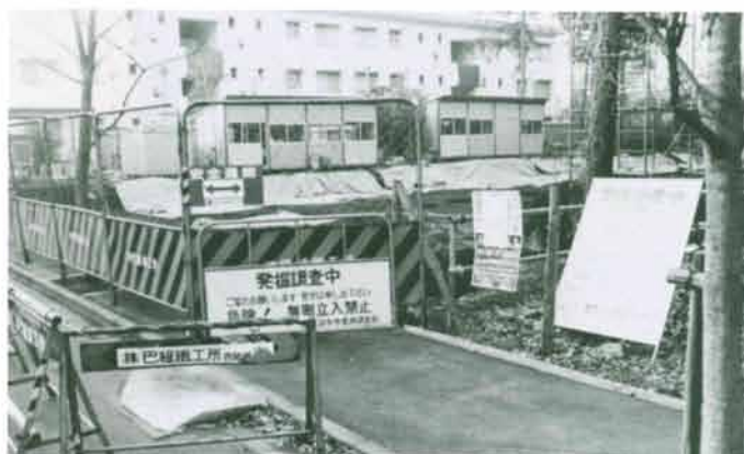
3. 仮囲い状況（北東から） 昭和59年12月22日
