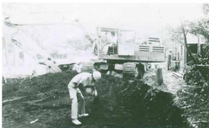
2. 表土掘削状況（西から） 昭和59年7月5日
