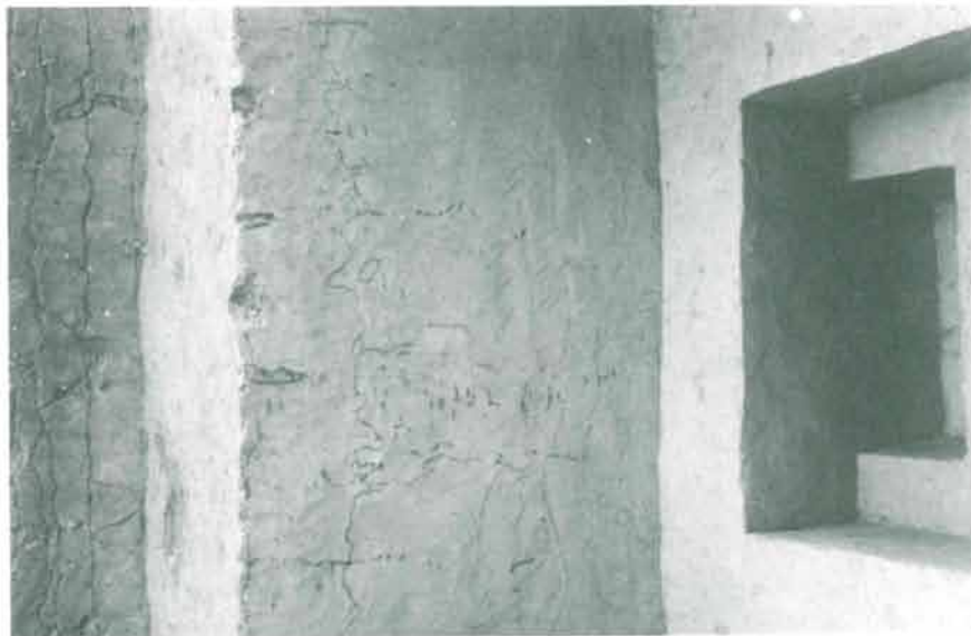
3. B地区南壁土層断面（北から）
