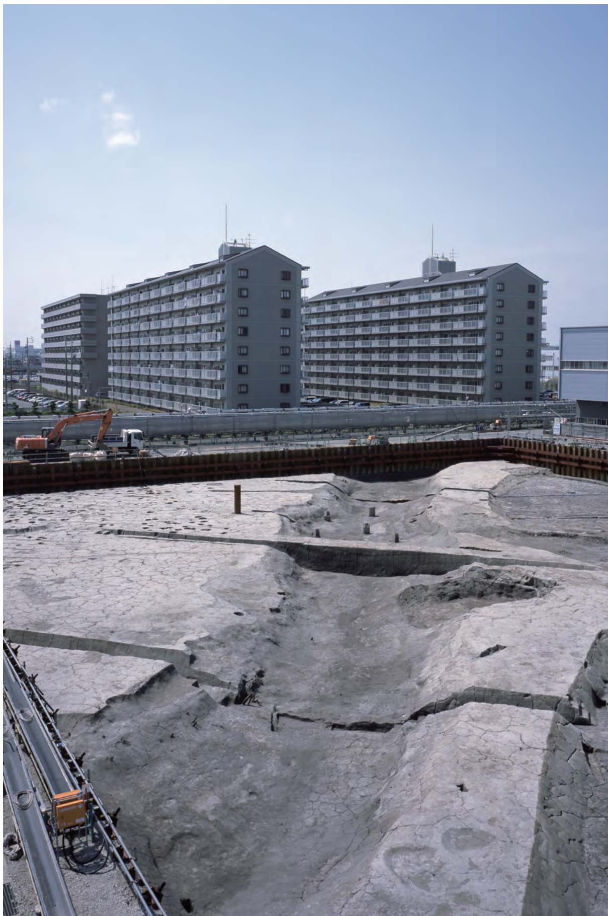
伊場大溝V層完掘状況（南東から）
