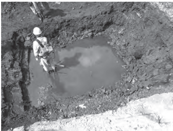
Fig. 16 工事立会の状況（E地点）
