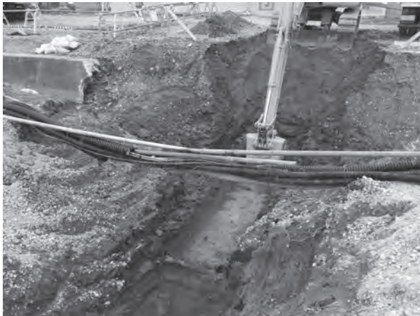
Fig. 15 工事立会の状況（C地点）
