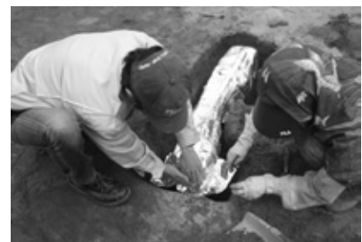
Fig.32 アルミ箔での保護
