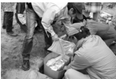
Fig.33 ウレタン樹脂の流し込み作業
