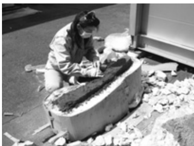
Fig.37 ウレタン解体作業
