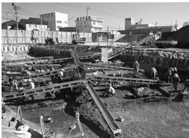
Fig.21 伊場大溝の調査風景
