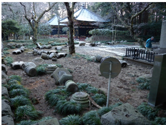
第 1 図 経ヶ峰伊達家墓所の被災状況
