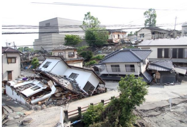
図 1 熊本県益城町における被害状況
