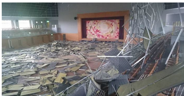
図 2 町有施設（総合体育館）の被害状況
