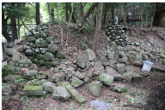
第10図 酉門石垣の崩落状況
