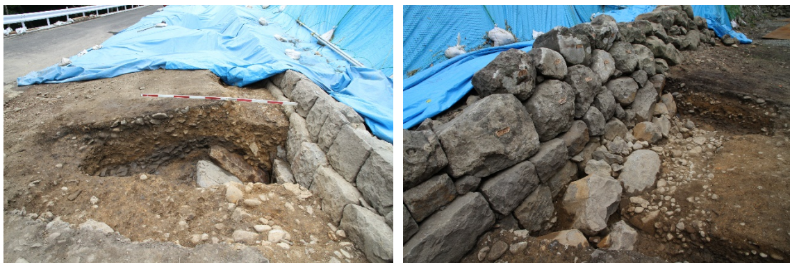
第 16 図 本丸北西石垣基部の様子
