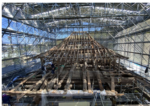
図 7 補助制度を活用し復旧が進む皆乗寺本堂
