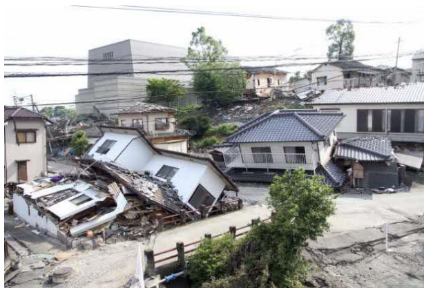
図 1 熊本県益城町における被害状況
