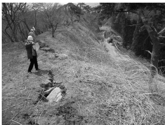
第 2 図 史跡岩切城跡の被災状況
