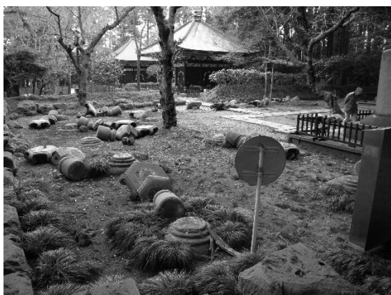
第 1 図 経ヶ峯伊達家墓所の被災状況
