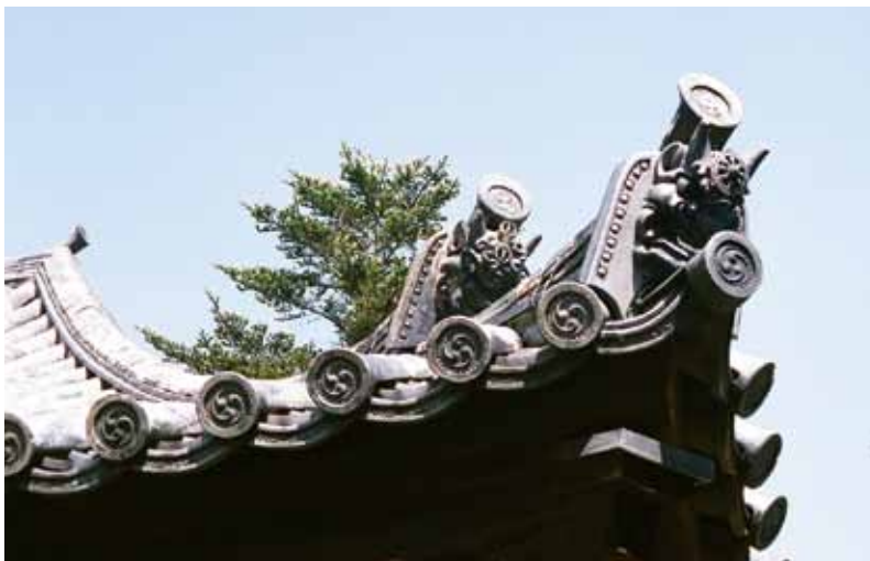
写真3 本蓮寺本堂の屋根
