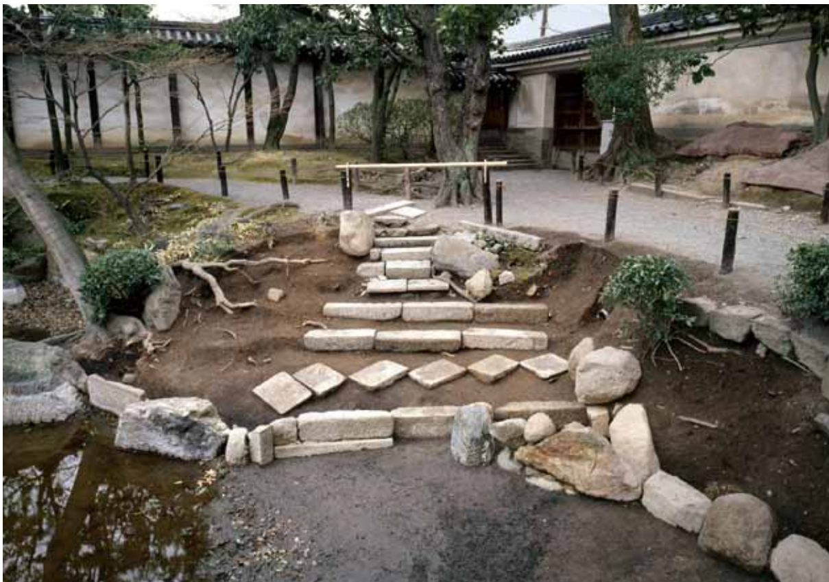
写真1 調査で確認した船着場の階段(南東から)
