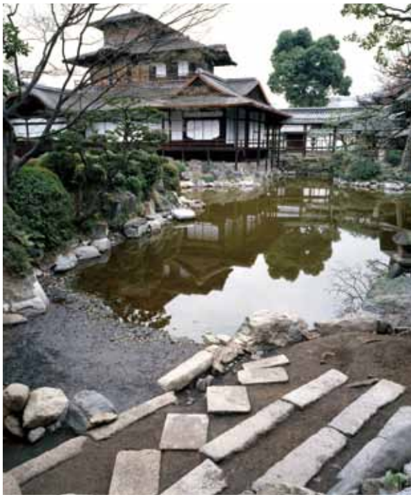
写真2 船着場から滄浪池と飛雲閣を見る（北西から）
