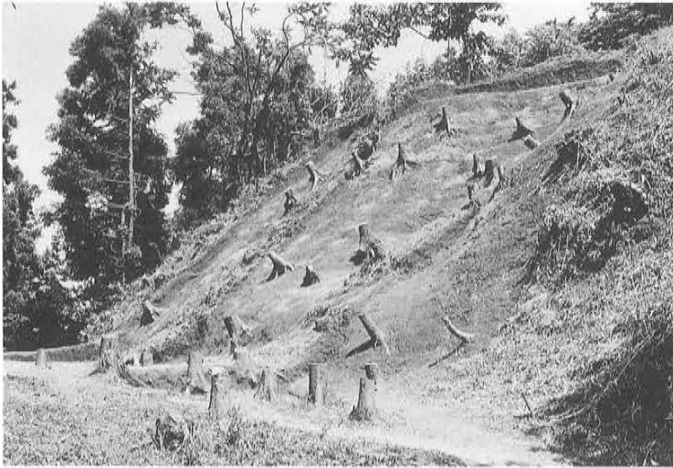
北第一堀切南面西から
