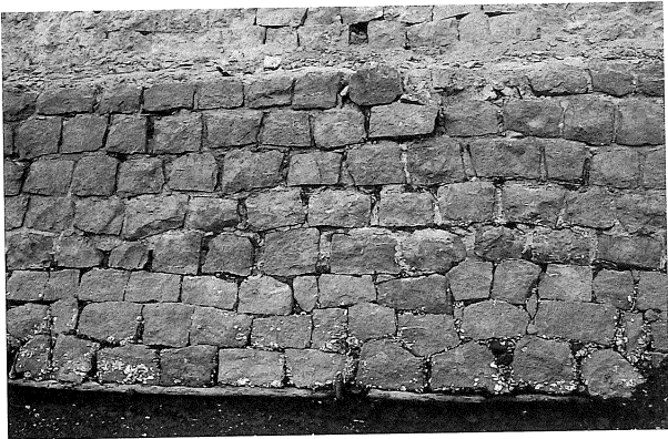
写真 63 末広開外側堤防下半部石積み状況
