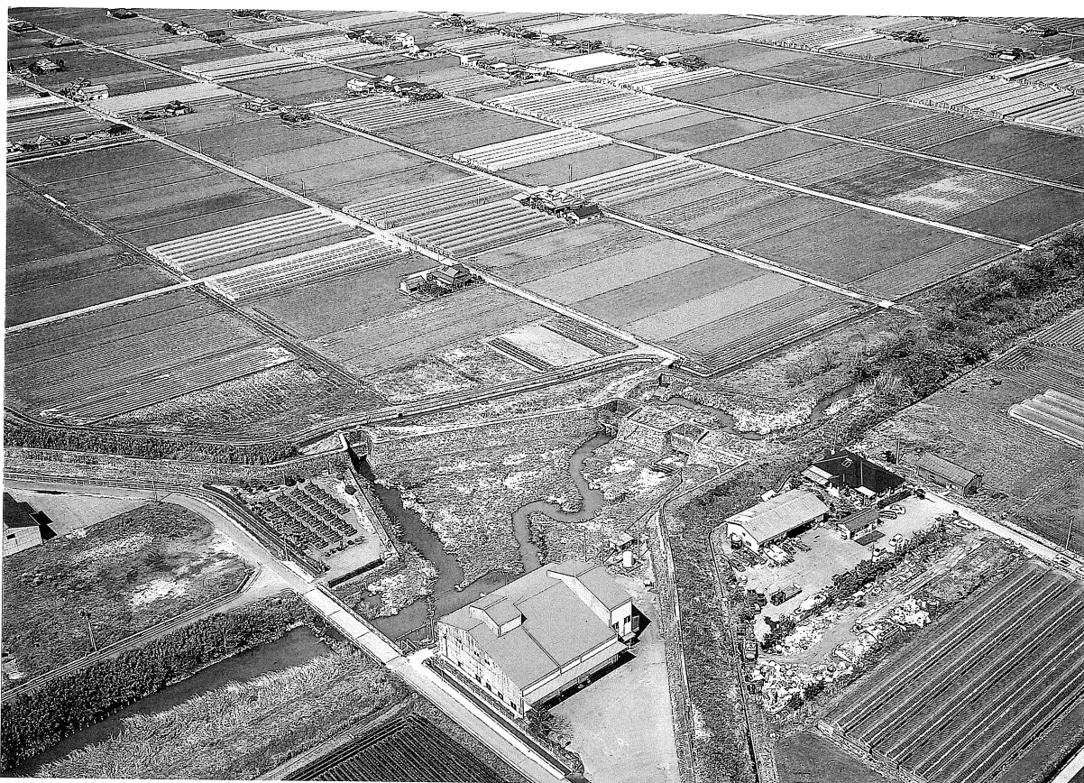
写真 32 末広開樋門の土砂除去前（南東から）
