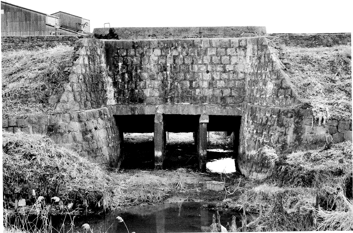
写真 40 末広開東三枚戸樋門（北から）
