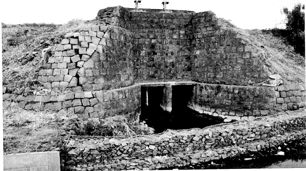
写真 46 末広開二枚戸樋門干拓地側（西から）
