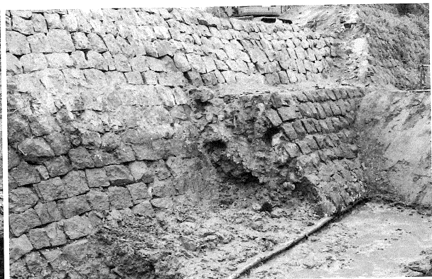
写真 66 末広開外側堤防下半部掘削状況
