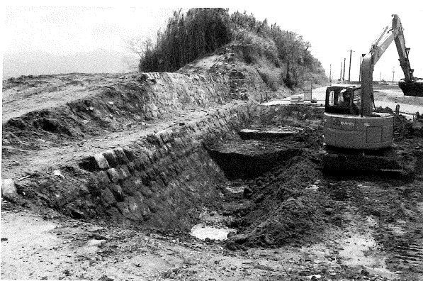
写真 60 末広開外側堤防掘削状況（西から）
