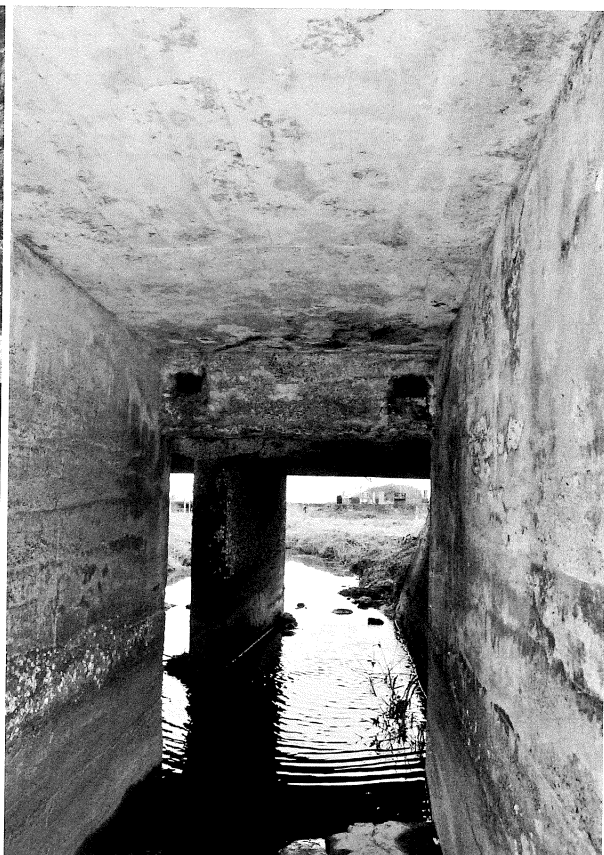
写真 44 末広開西三枚戸樋門の通水路内部
