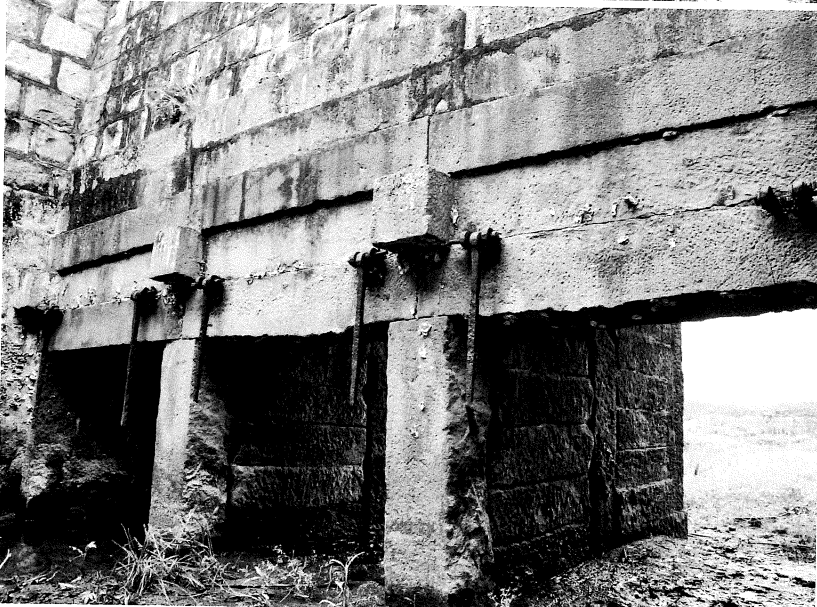
写真 38 未広開東三枚戸樋門招戸設置部分
