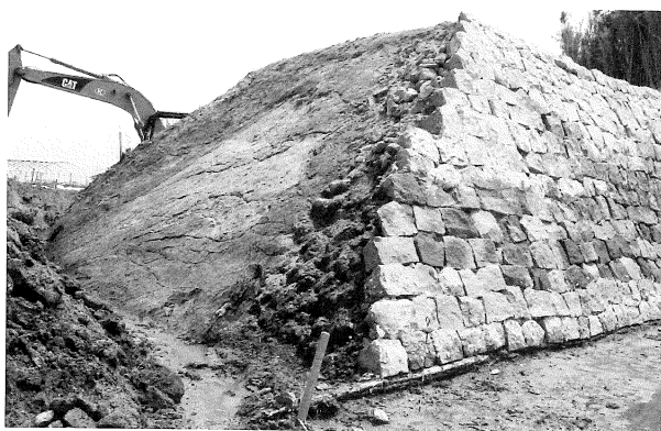
写真 68 末広開内側堤防掘削状況（南西から）
