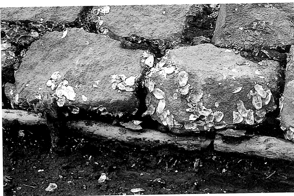
写真 65 末広開外側堤防基礎部分
