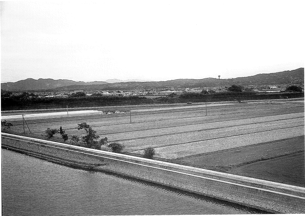
写真 54 明豊開潮受堤防（南西から）
