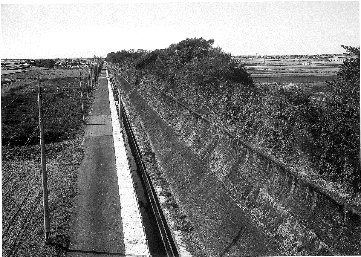
写真 55 大豊開潮受堤防（東から）
