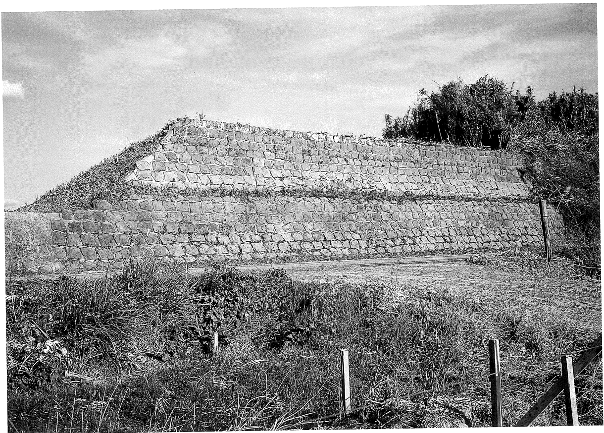
写真 57 末広開潮受堤防水路掘削前（南から）
