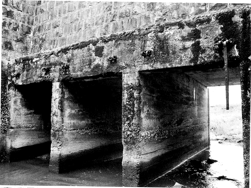
写真 37 未広開西三枚戸樋門招戸設置部分
