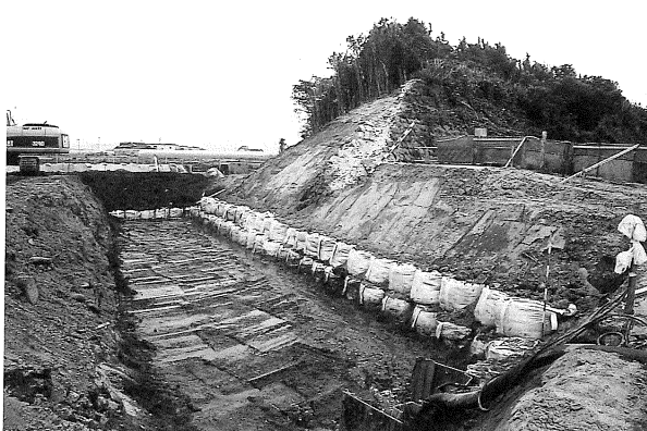
写真 74 水路工事掘削状況
