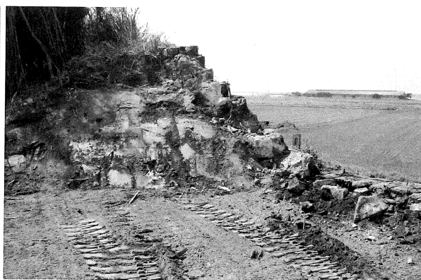
写真 59 末広開潮受堤防上半部掘削（西から）
