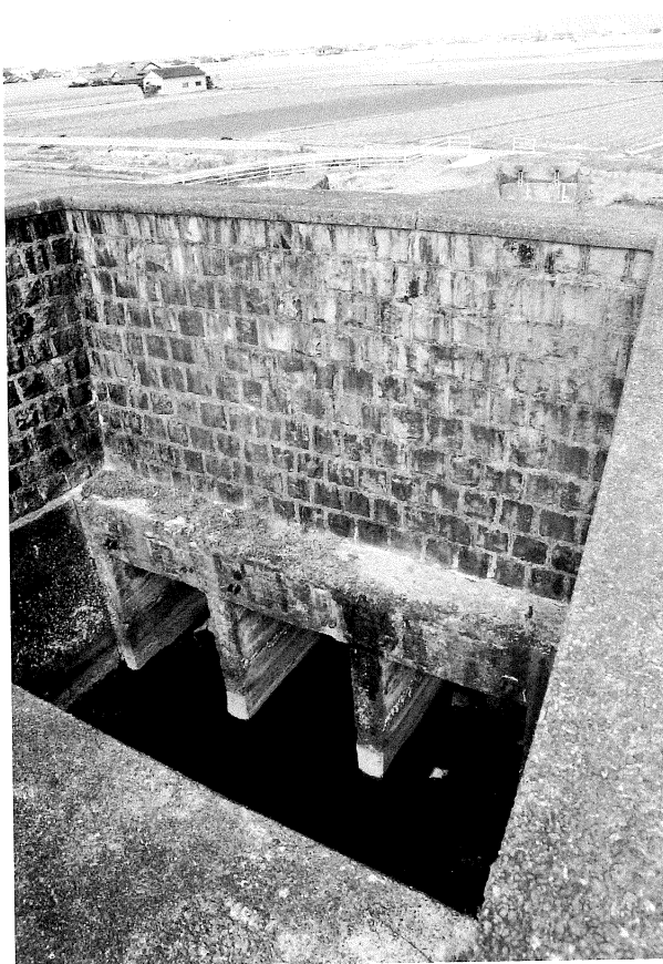
写真 35 末広開西三枚戸樋門の招戸設置面
