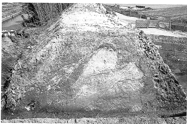
写真 69 末広開内側堤防土層断面（西から）
