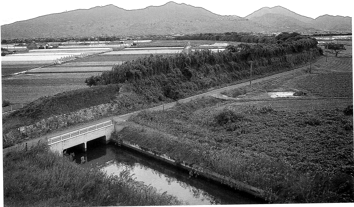
写真 56 末広開潮受堤防全景（水路掘削工事後、西から）
