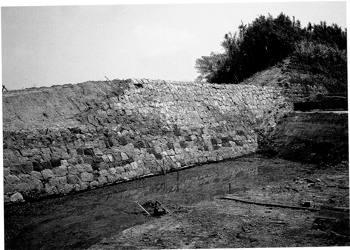
写真 67 末広開内側堤防（南西から）
