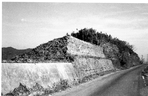
写真 58 末広開潮受堤防水路掘削前（西から）
