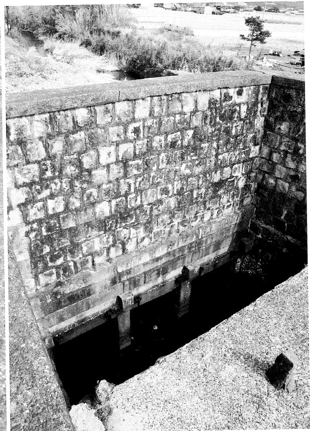
写真 36 末広開東三枚戸樋門の招戸設置面
