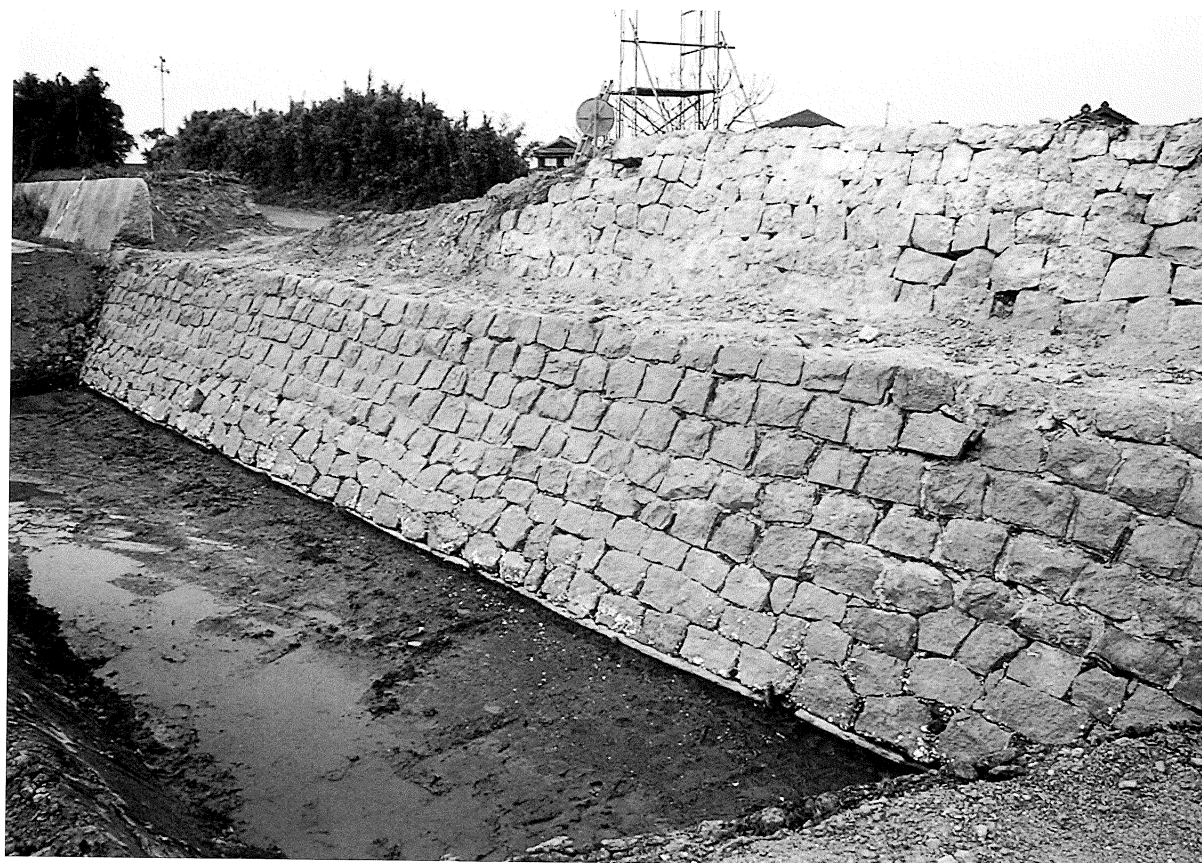
写真 62 末広開外側堤防下半部（南東から）
