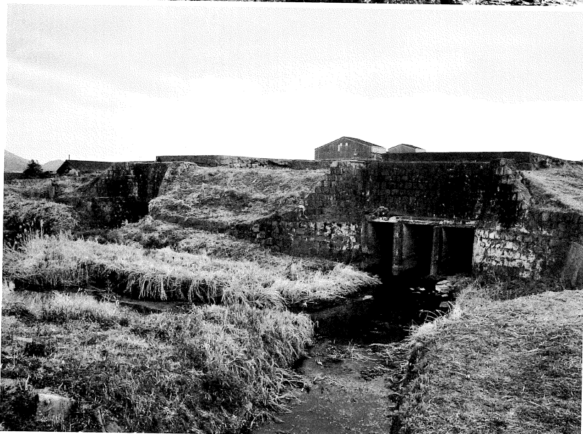
写真 39 右：未広開西三枚戸樋門 左：未広開東三枚戸樋門（北から）
