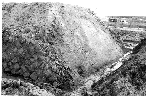
写真 71 末広開内側堤防掘削状況（北から）
