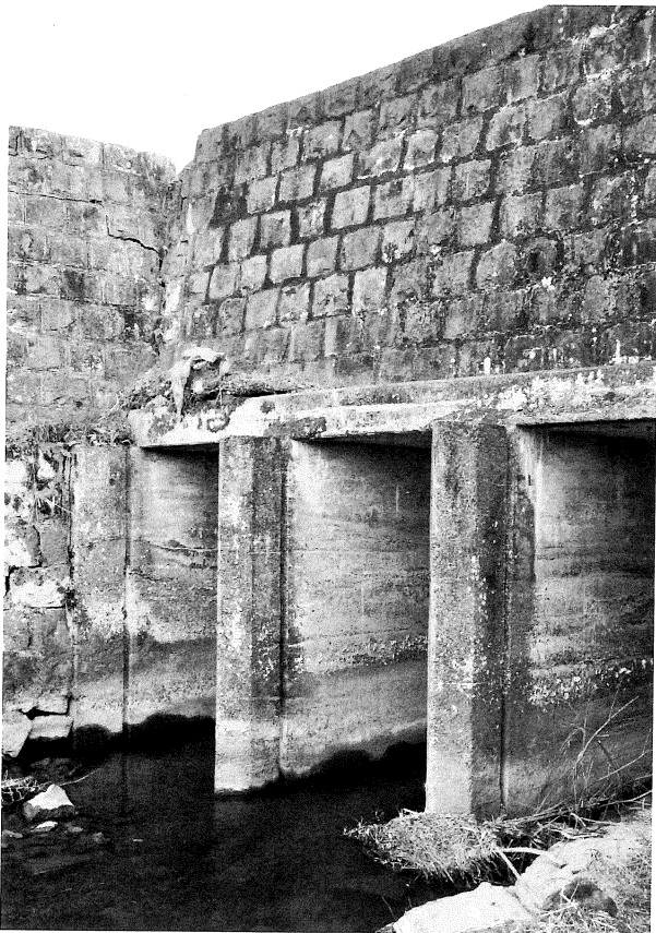
写真 43 末広開西三枚戸樋門通水路（北から）
