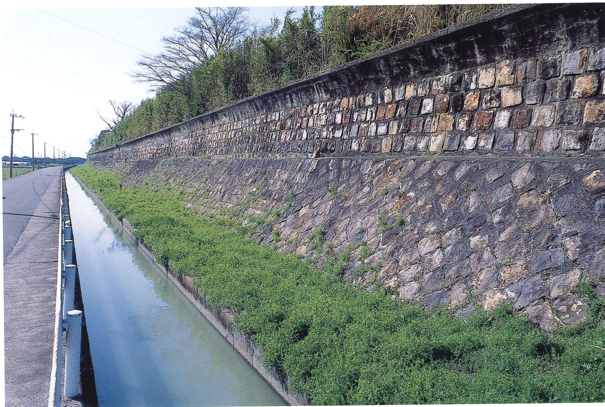
明丑開潮受堤防（東から）
