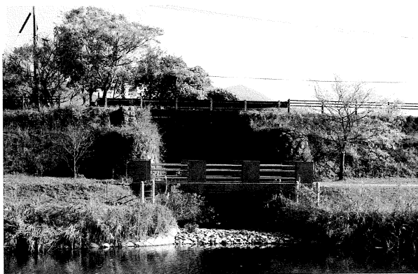
写真 20 十番開北側樋門海側（西から）
