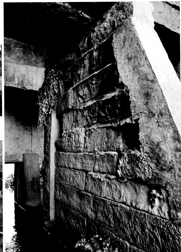
写真 22 十番開北側樋門干拓地側通水路隔壁面
