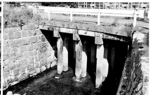
写真8 新井樋（西から）
