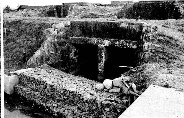
写真 19 六枚戸北側樋門干拓地側（北から）
