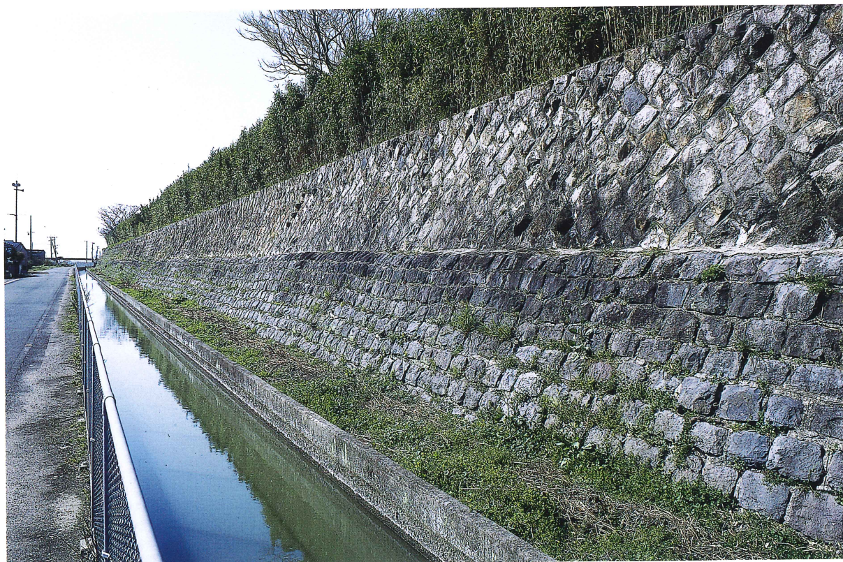
末広開潮受堤防（東から）
