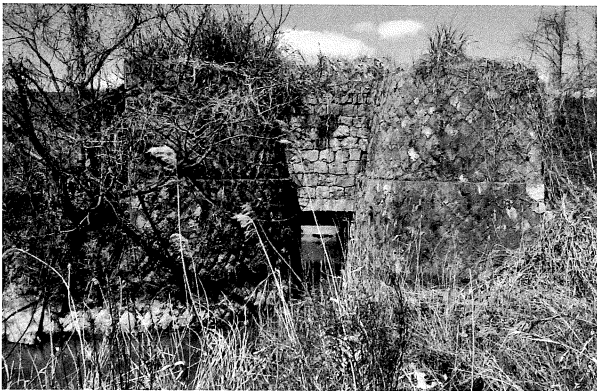
写真 24 十番開南側樋門干拓地側（東から）
