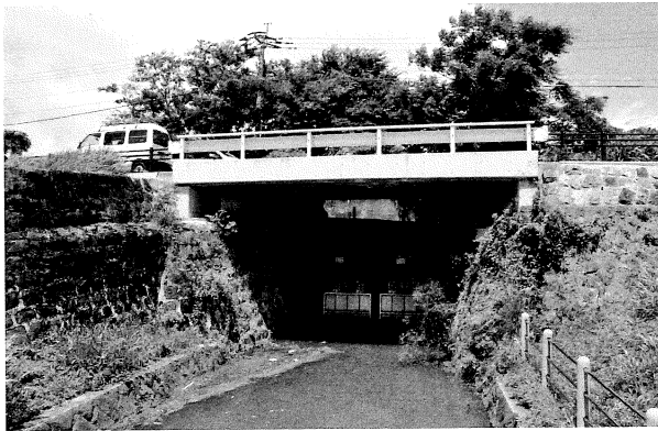
写真 16 明丑開樋門海側（東から）
