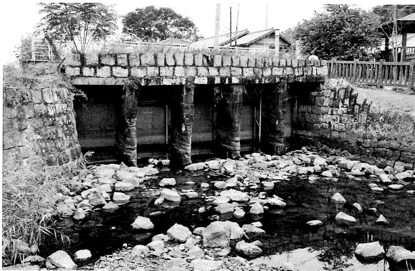
写真7 新内井樋（西から）
