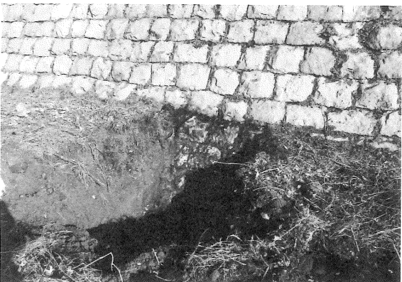
写真175 末広開堤防跡隣接地3T全景
