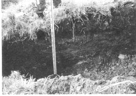
写真80 市道岱明玉名線予定地13T土層断面
