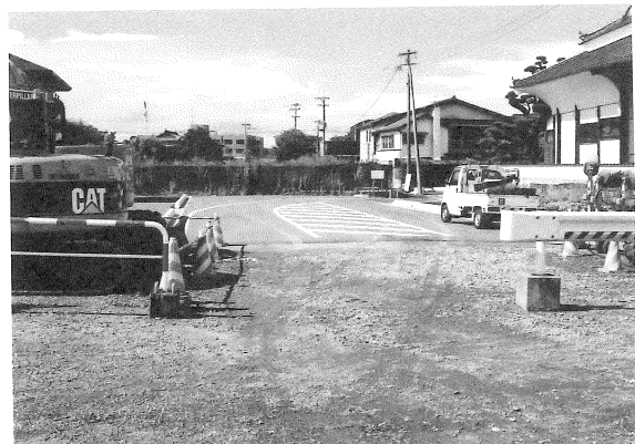
写真7 市道立願寺横町線予定地全景3
