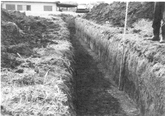
写真91 市道岱明玉名線予定地21T土層断面
