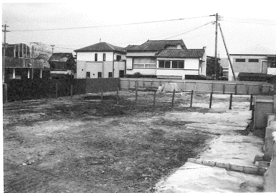
写真6 市道立願寺横町線予定地全景2
