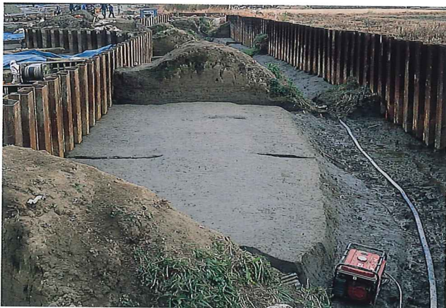
5 11区の畦畔状遺構（西より）
