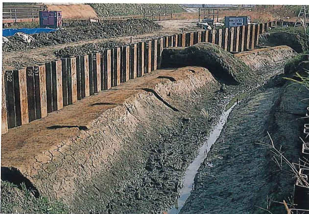
7 13区の畦畔状遺構（西より）
