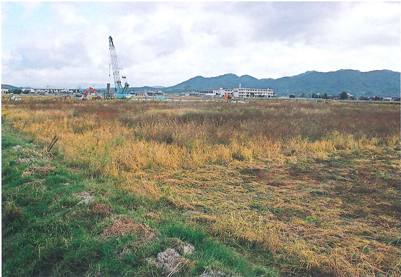
1 調査Ⅱ区付近（南西から）
