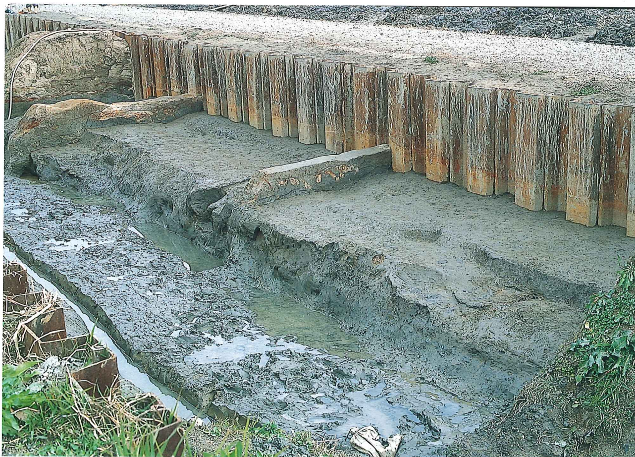
3 4区の沈砂溝状遺構（南西より）
