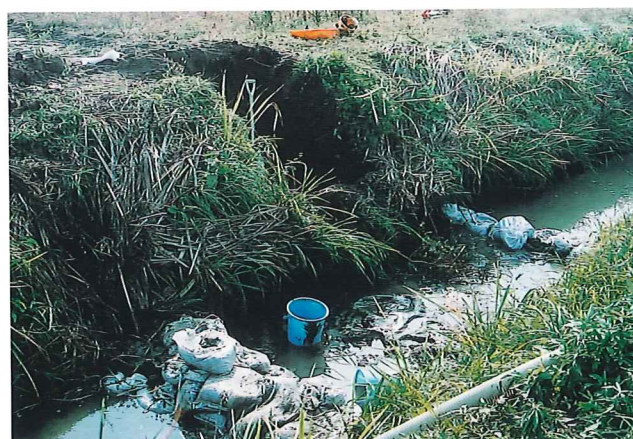
4 3 トレンチ水路際掘削状況 (北東から)
