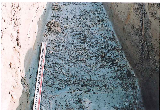
3 24トレンチ杭検出状況
