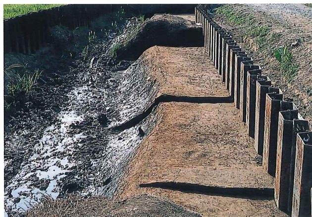
4 12区の畦畔状遺構（東より）
