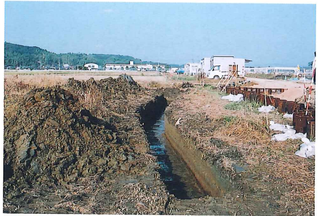
2 7トレンチ掘削状況 (南から)
