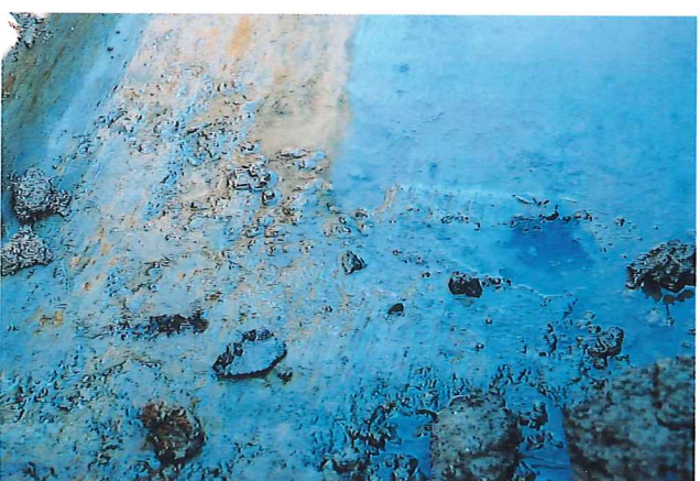
8 34トレンチ杭検出状況
