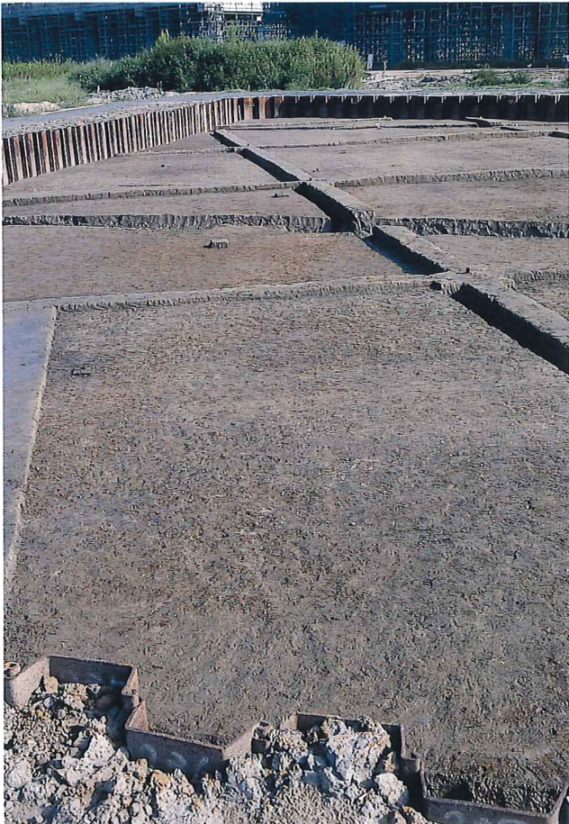
1 杭列検出状況（南から）
