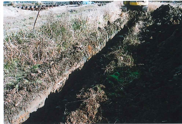
6 57トレンチ掘削状況（西から）
