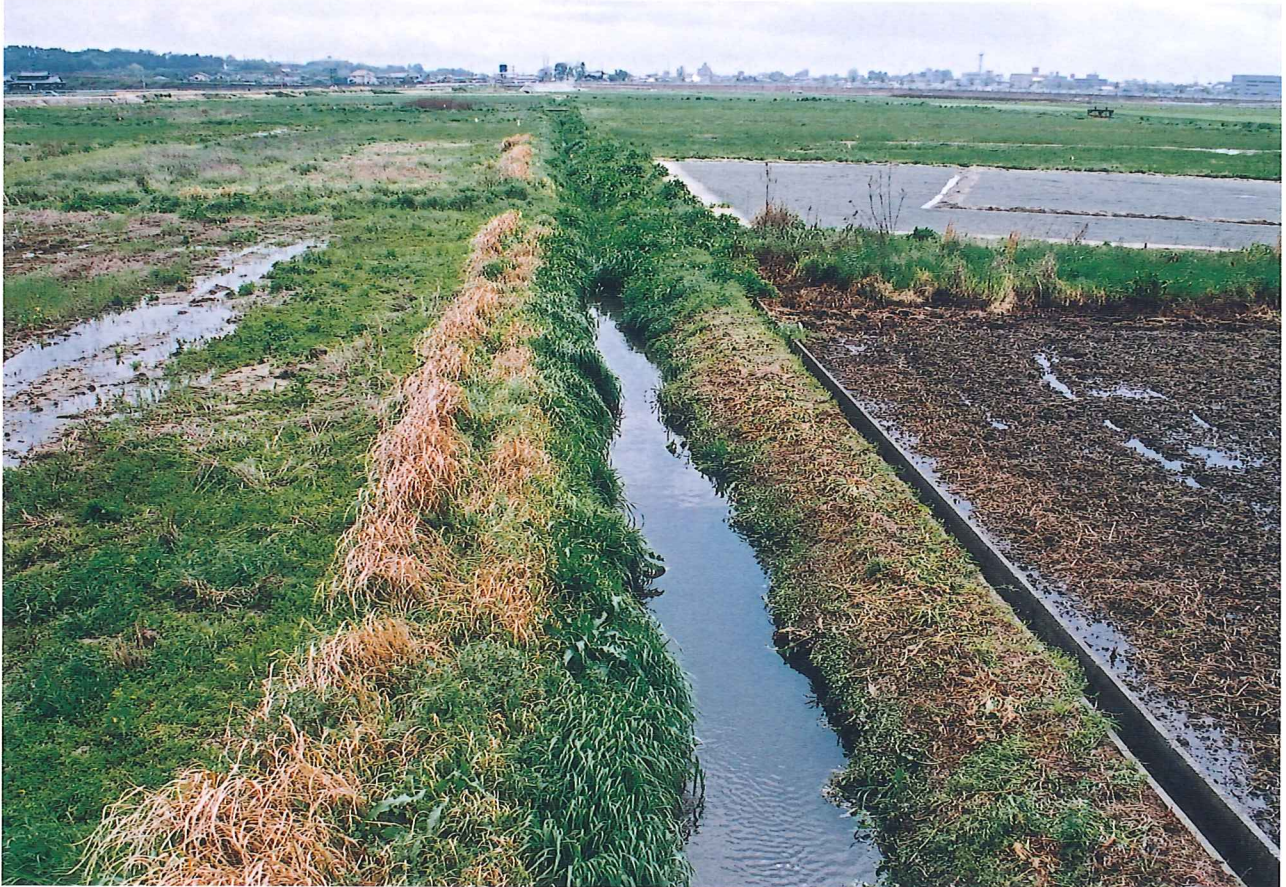
1 中央水路（北から）
