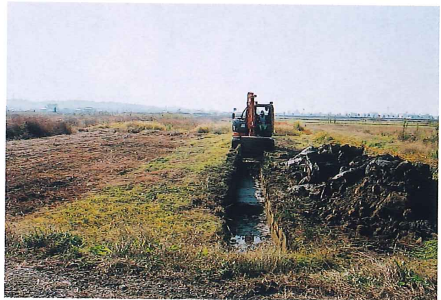
6 11トレンチ掘削状況 (北から)
