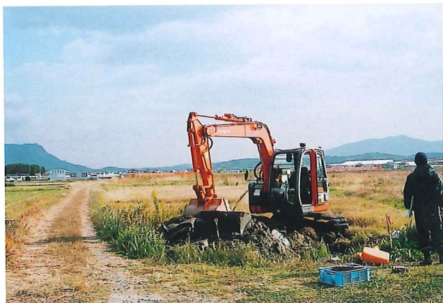
1 1 トレンチ掘削状況 (東から)
