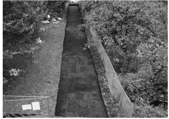
2 塔2周辺 西トレンチ全景 (西から)
