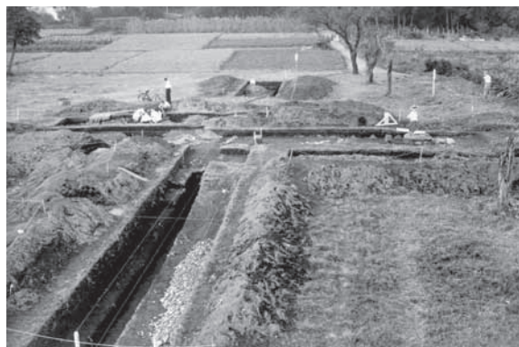
8 昭和 31 年度講堂調査 (南から)
