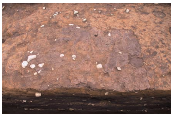
4 講堂 5-1 区 SB218A-6-2 礎石据え付け痕跡 (南から)
