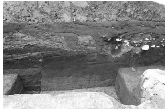
3 金堂6区旧トレンチ SB217 基壇・掘込地業・ 外装土層断面（東から）
