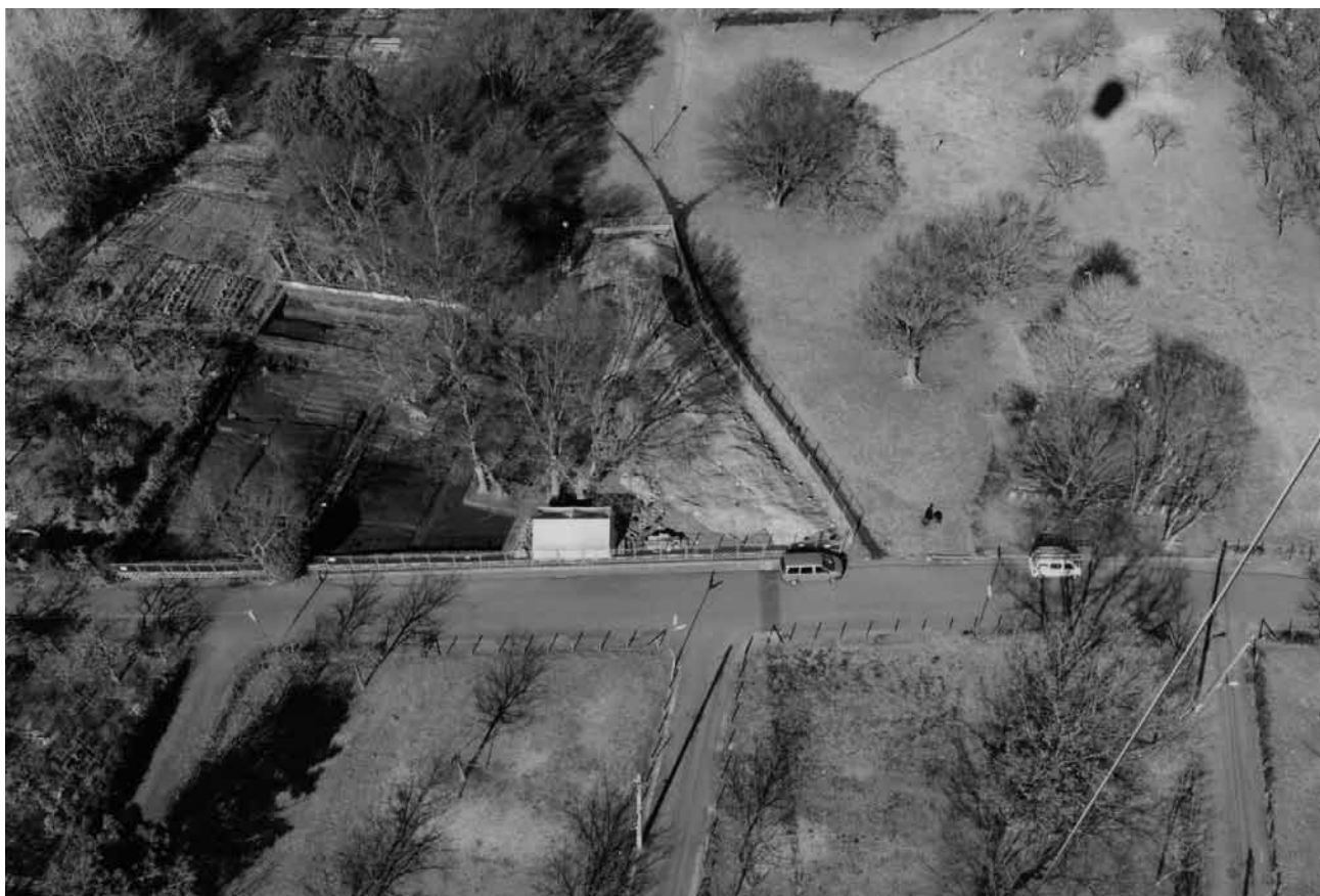
5 塔1・塔2 全景 (南から)
