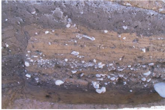
1 講堂 2 区旧トレンチ SB218B 版築断面 (北から)
