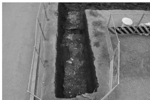
3 中門・金堂間 SX307 (西から)
