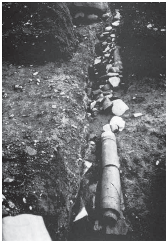
2 昭和 40 年代講堂調査 創建講堂瓦積基壇外装 (北から)
