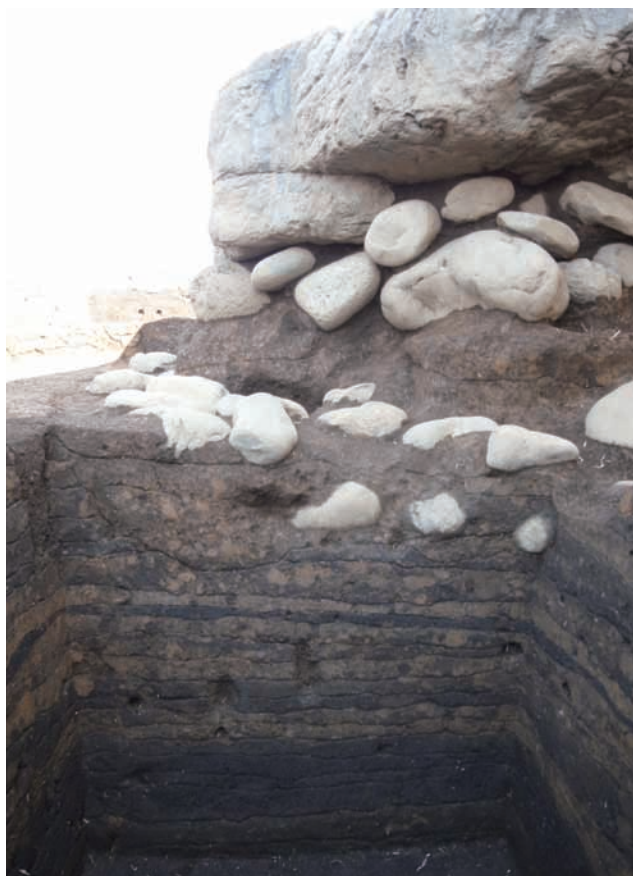
2 金堂20区 SB217-4-4 礎石 据付断面 (西から)
