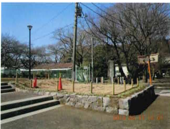
築地塀状遺構の保護を図った整備状況（北東から）
