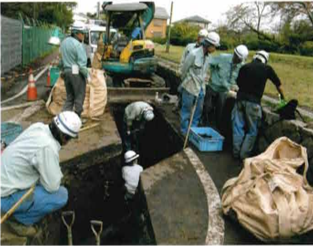
ガス工事立会作業風景（北西から）
