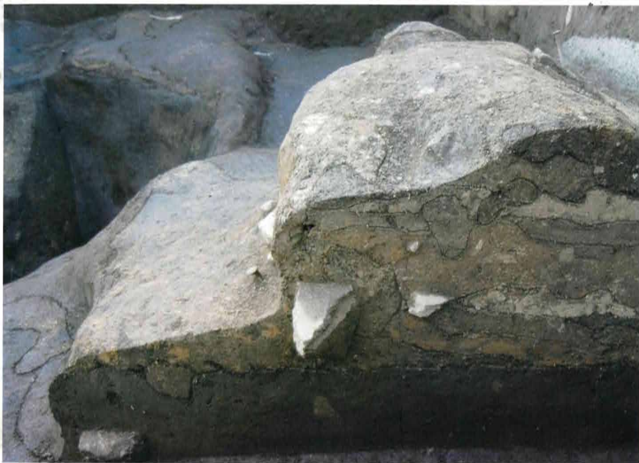
伽藍中枢部区画施設（北西地区）築地塀版築の断割り断面（東から） ※黒色土を基底部に据え，ロームと白色粘土の互層で積上げている。 部分的に瓦片が混入する。
