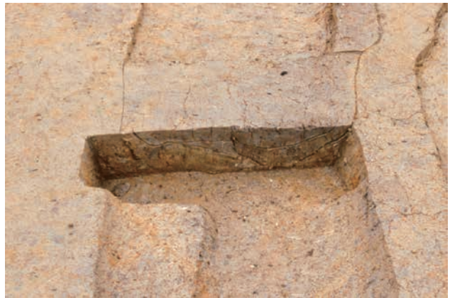
C区第1面 SK02土層断面(西から)
