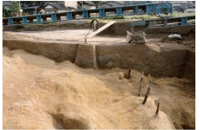
4-Ⅲ区 SX06 土層断面と杭列 (北から)
