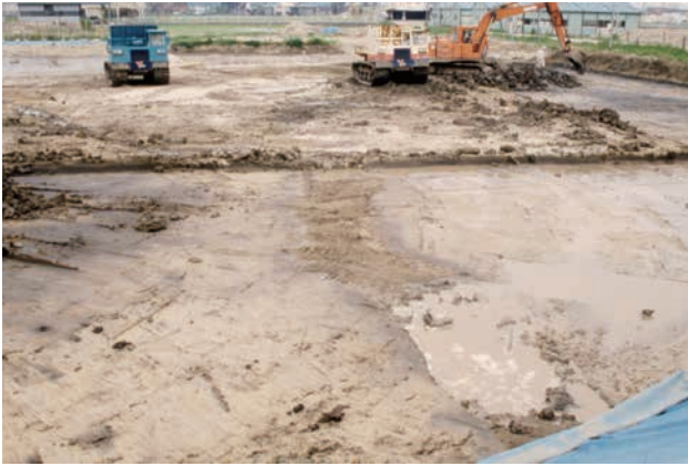
2区中層堆積層の重機掘削
