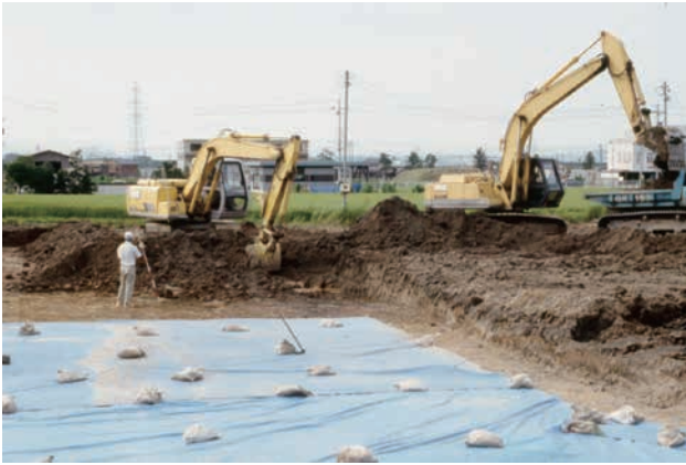
1区表土の重機掘削
