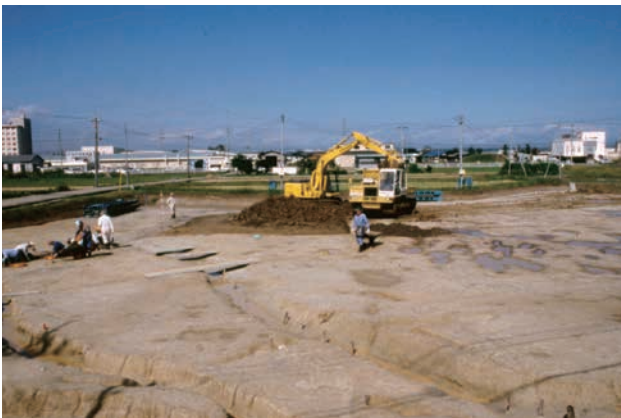
1区上層堆積層の重機掘削
