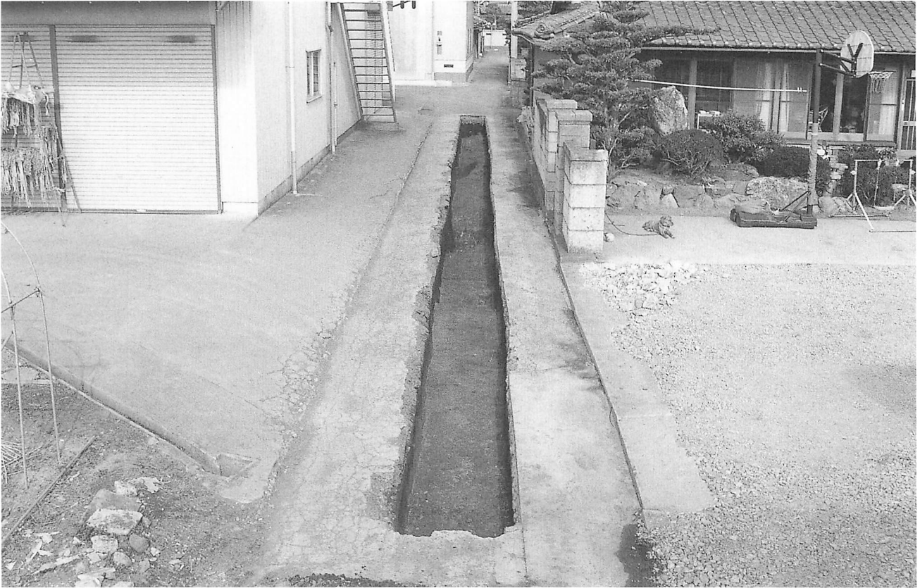
調査区北部全景（南から）
