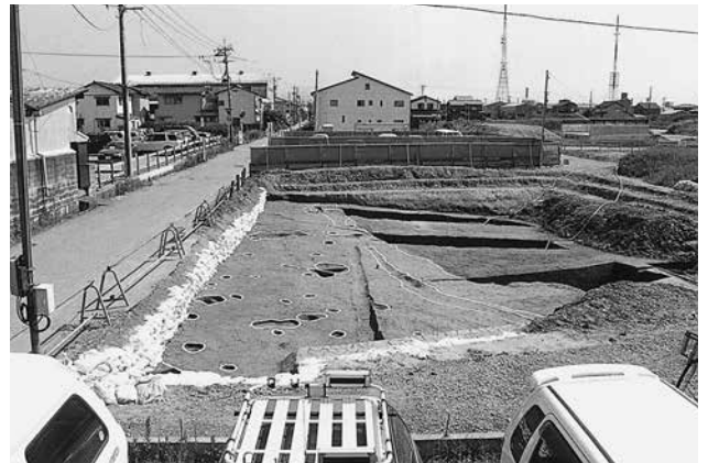
東部遺構検出状況
