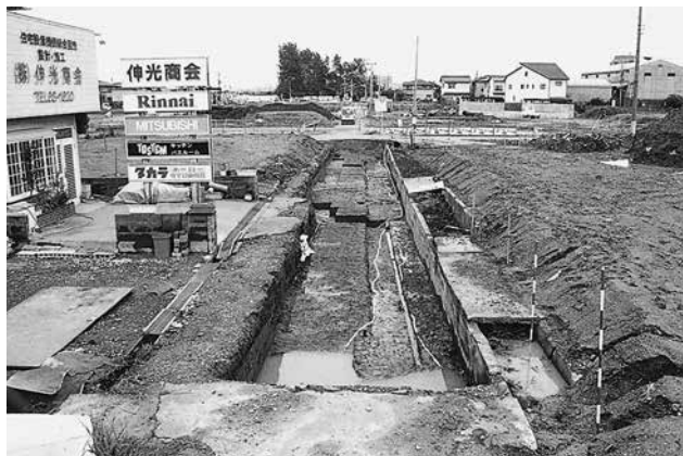
中部完掘状況 (西から)
