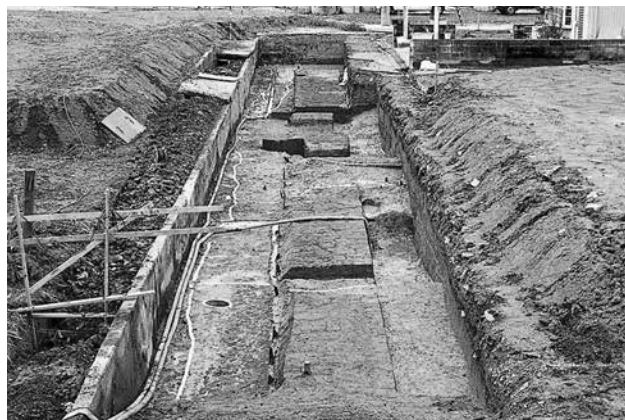
中部完掘状況 (東から)
