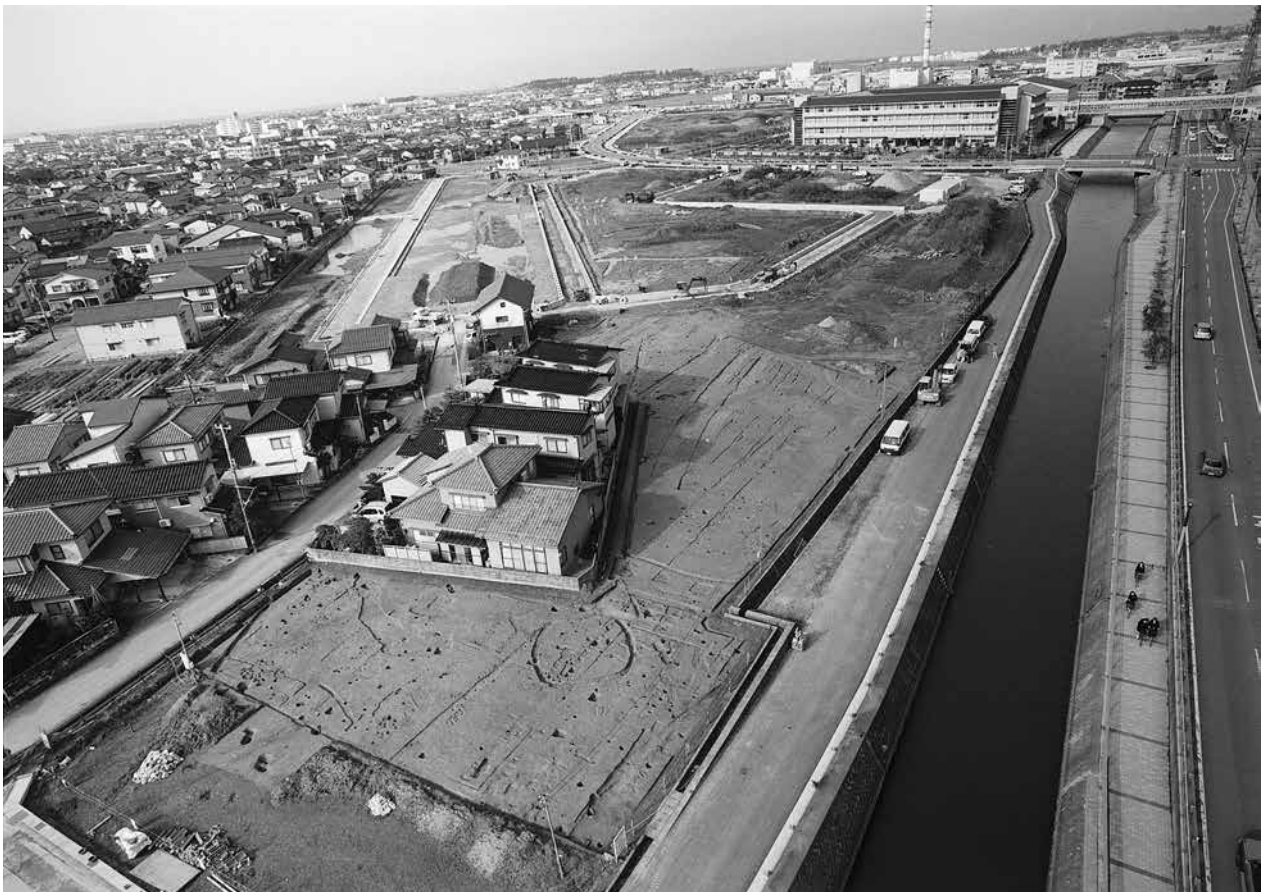
D3区全景（南東から）
